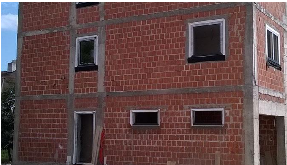
Slika 5.2 RAL ugradnja stolarije [34]
