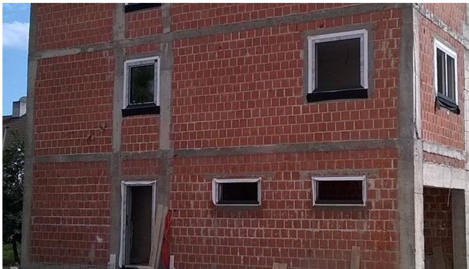
Slika 5.2 RAL ugradnja stolarije [34]
