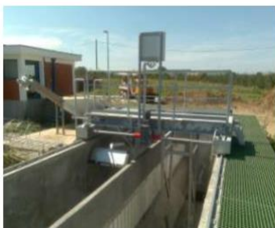
Slika 4.7. Primjer aeriranog pjeskolova-mastolova i pokretnog mosta sa zgrtačima pijeska i masti za dvije linije [12]
