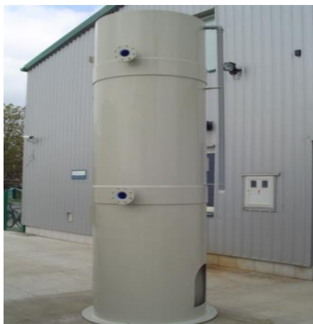
Slika 4.11. Primjer biofiltera za pročišćavanje zraka [15]
