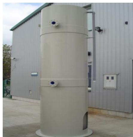
Slika 4.11. Primjer biofiltera za pročišćavanje zraka [15]
