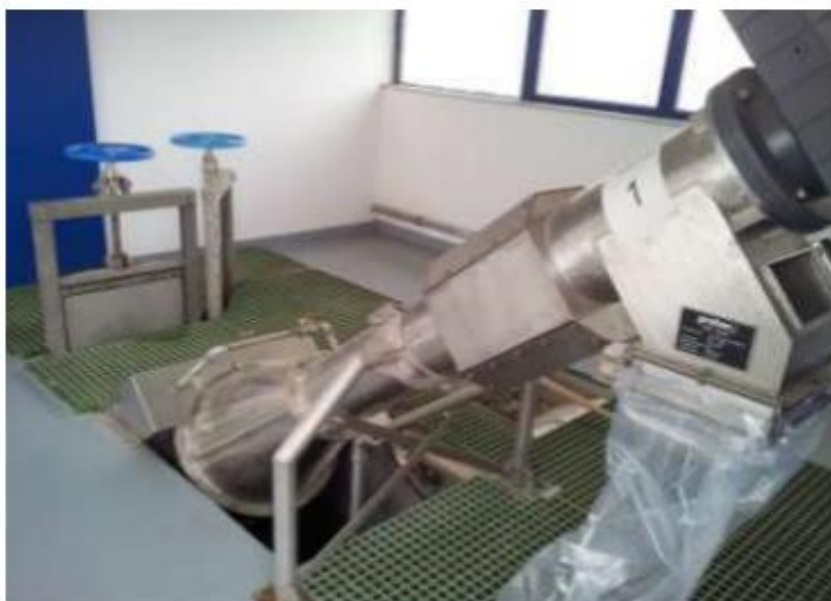
Slika 4.4. Primjer fine rešetke-sita [12]
