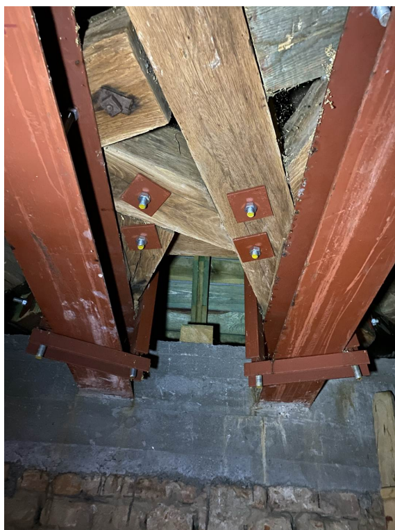
Slika 6.46. Novi nosivi sustav južne lukovice zvonika, čelični profili umetnuti u horizontalnu gredu
