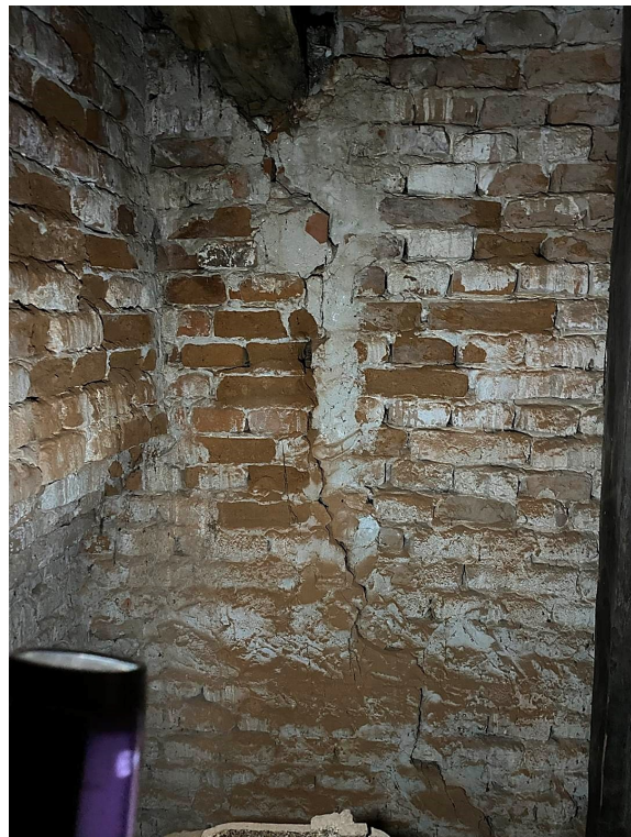
Slika 9.1. Vertikalna pukotina uz južni zvonik crkve, K6
