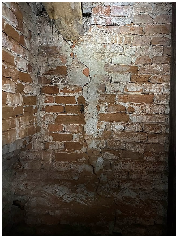
Slika 9.2. Vidljivi nagib sjevernog zvonika te oštećeni zid uz sjeverni toranj zvonika crkve
