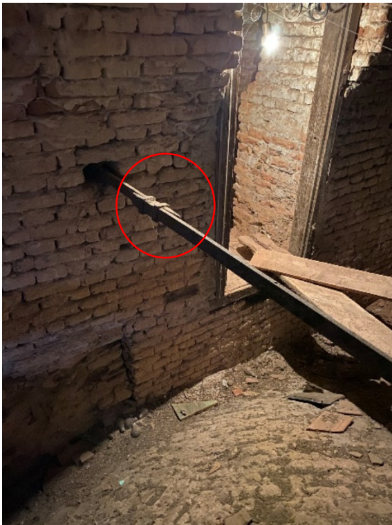
Slika 6.41.K3, prikaz spoja zvonika (na klin)
