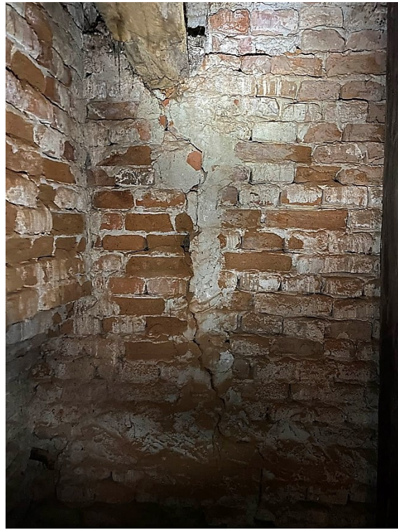
Slika 6.45. Vidljivi nagib sjevernog zvonika te oštećeni zid uz sjeverni toranj zvonika crkve
