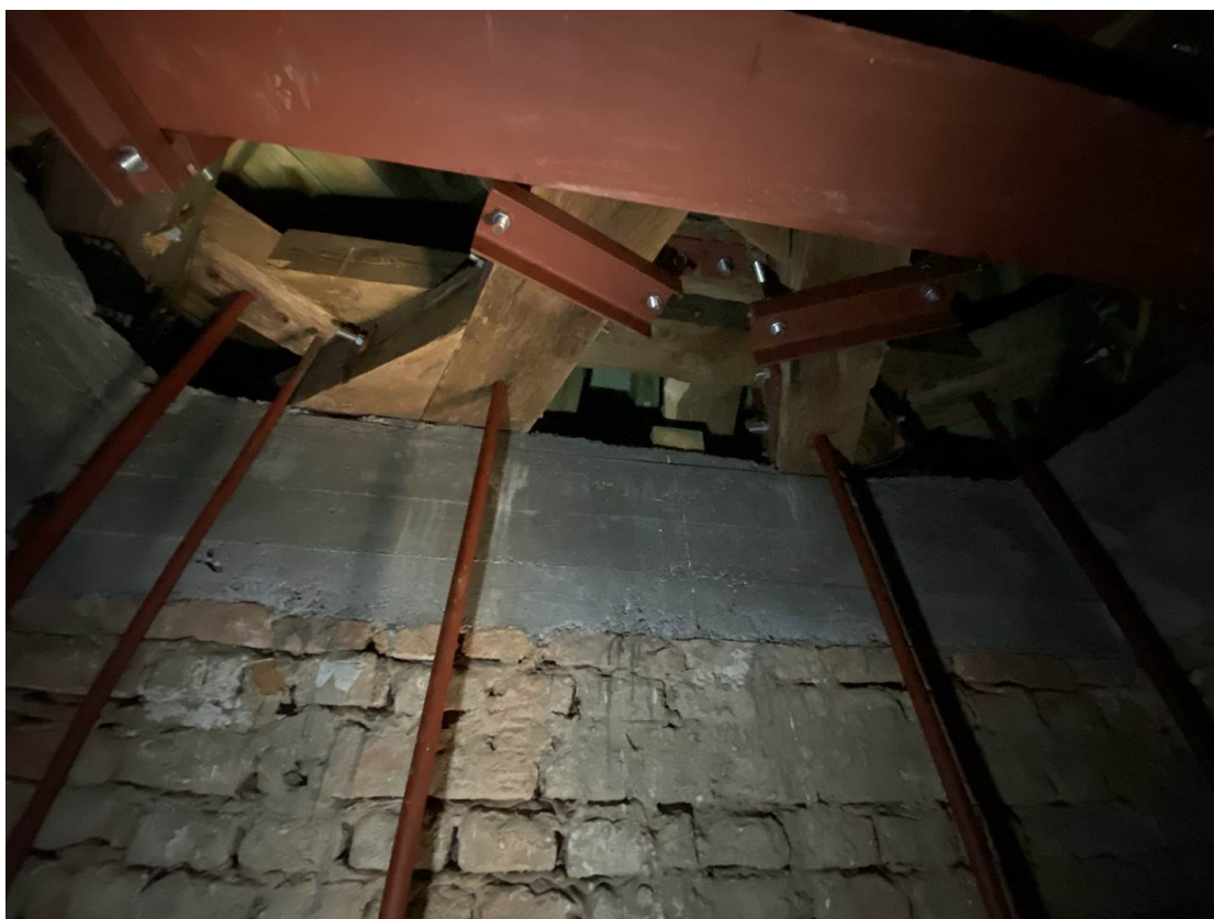
Slika 6.47. Vertikalna sidra (čelične šipke) za sidrenje cijele lukovice zvonika
