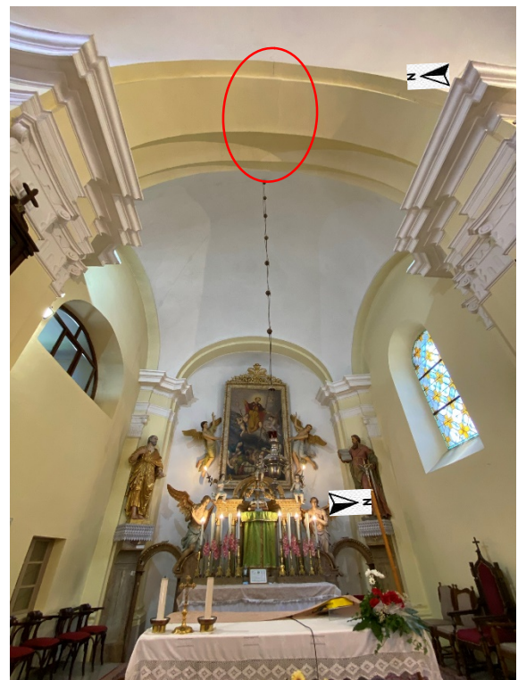
Slika 6.17.Glavni svod crkve te pukotina na trijumfalnom luku svetišta O10
