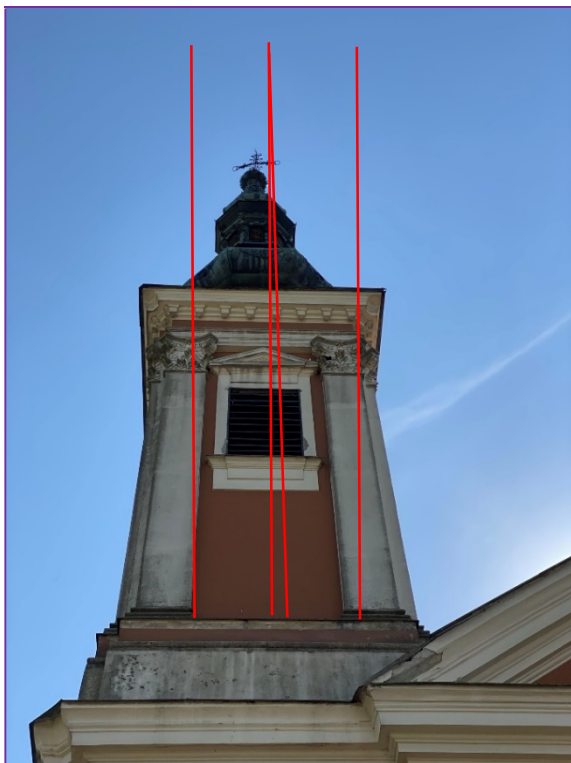
Slika 9.2. Vidljivi nagib sjevernog zvonika te oštećeni zid uz sjeverni toranj zvonika crkve
