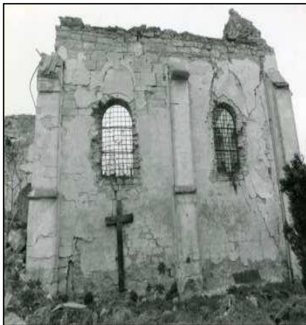
Slika 9. Pogled na južno pročelje crkve
