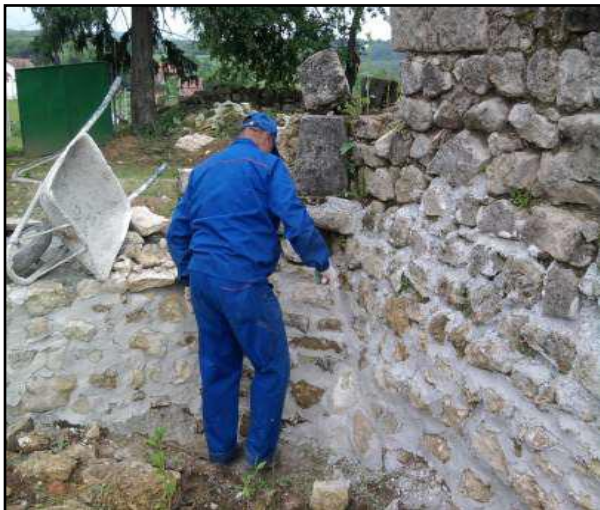
Slika 39. Špricanje temelja mortom
