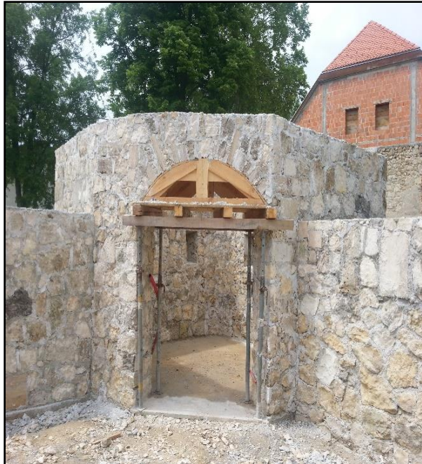
Slika 104. Oplata kamenog nadvoja
