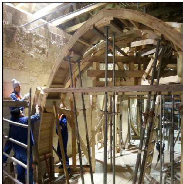
Slika 62. Zidanje svodova
