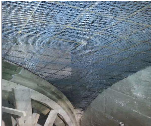
Slika 67. Detalj mrežaste armature stropa (2)
