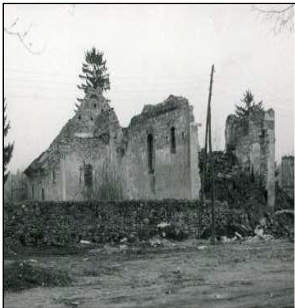
Slika 11. Pogled na sjeverno pročelje crkve
