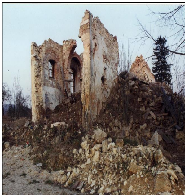
Slika 8. Pogled na zapadno pročelje crkve
