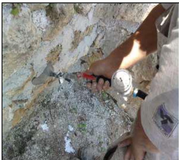
Slika 43. Injektiranje temelja
