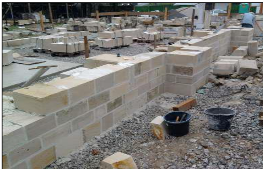
Slika 48. Pogled na zidanje sjevernog zida
