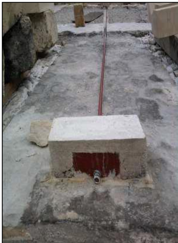
Slika 46. Zatege na temeljnoj ploči
