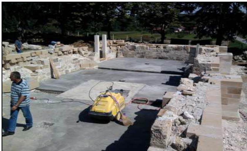
Slika 47. Pogled na zidanje južnog zida
