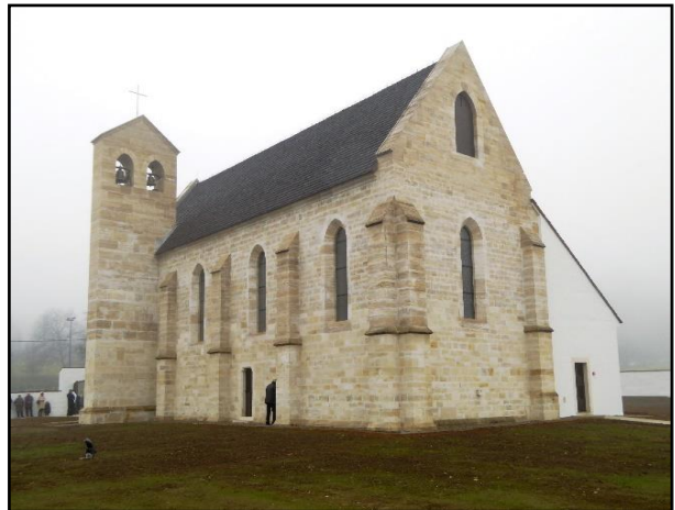
Slika 120. Pogled na sjeverno pročelje
