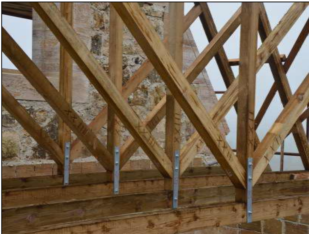
Slika 83. Izvedeni detalj krovišta "D"
