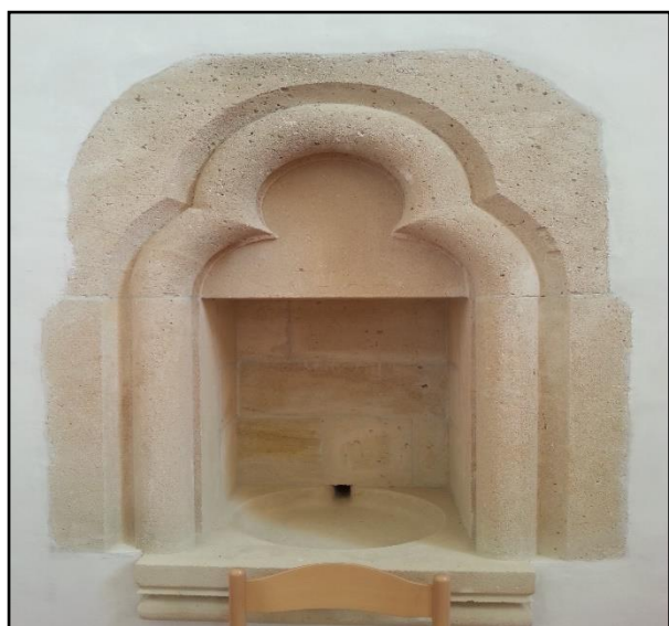
Slika 92. Restauriran sakrarij na južnom zidu
