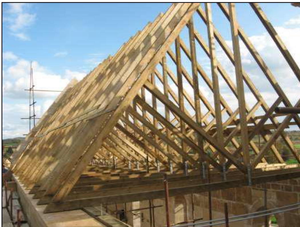
Slika 79.. Izvedeni detalj krovišta "B"
