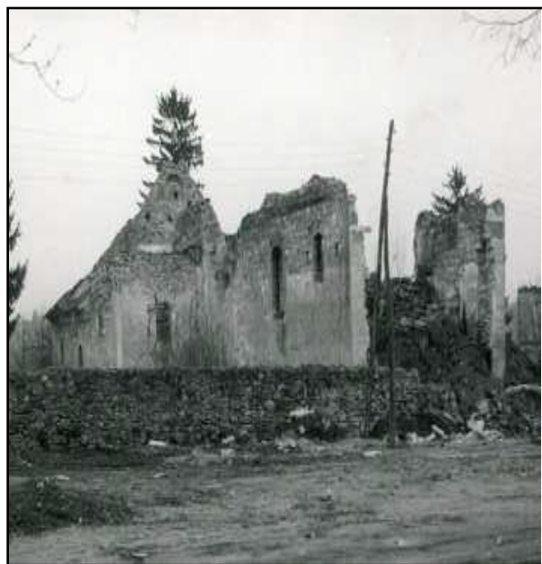
Slika 11. Pogled na sjeverno pročelje crkve
