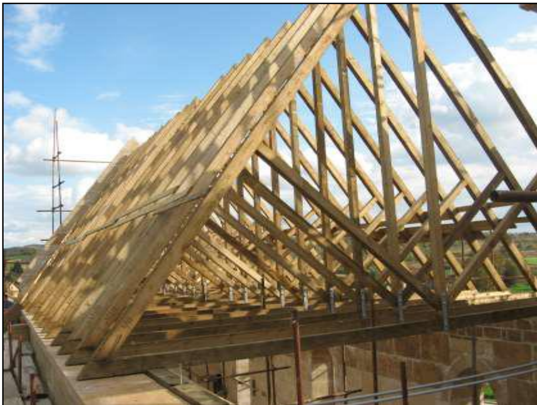
Slika 79.. Izvedeni detalj krovišta "B"
