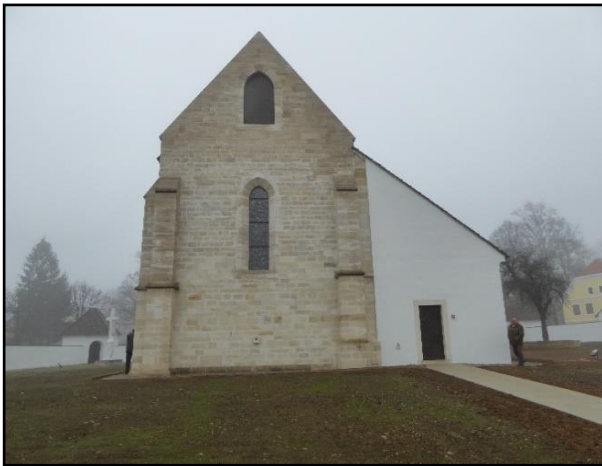
Slika 119. Pogled na istočno pročelje
