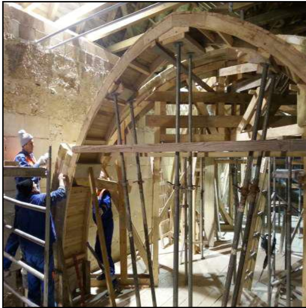
Slika 62. Zidanje svodova
