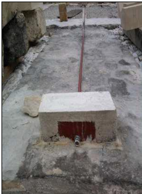
Slika 46. Zatege na temeljnoj ploči
