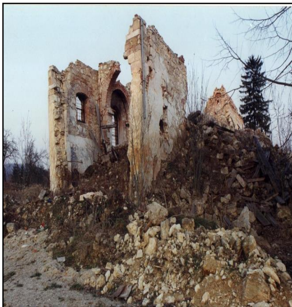
Slika 8. Pogled na zapadno pročelje crkve
