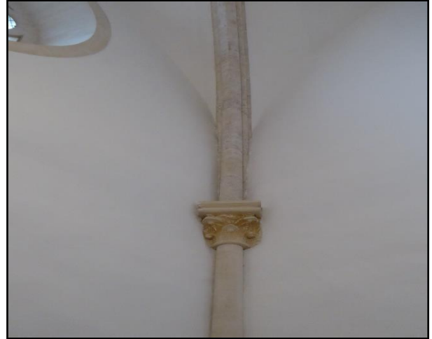
Slika 124. Detalj kapitela i svoda
