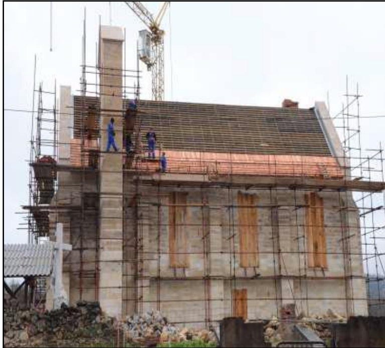
Slika 72. Postavljanje šindre (1)
