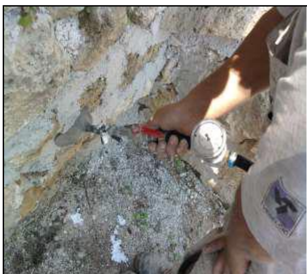
Slika 43. Injektiranje temelja
