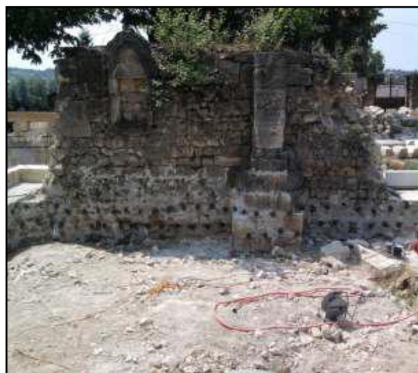
Slika 44. Podgled na injektirani temelj
