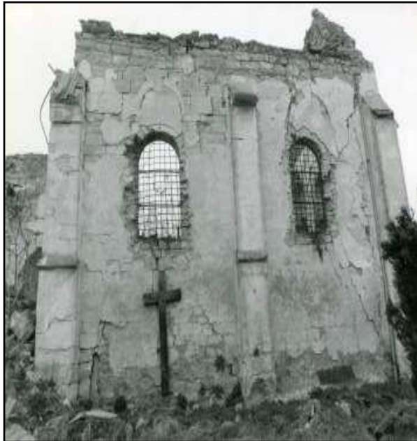
Slika 9. Pogled na južno pročelje crkve
