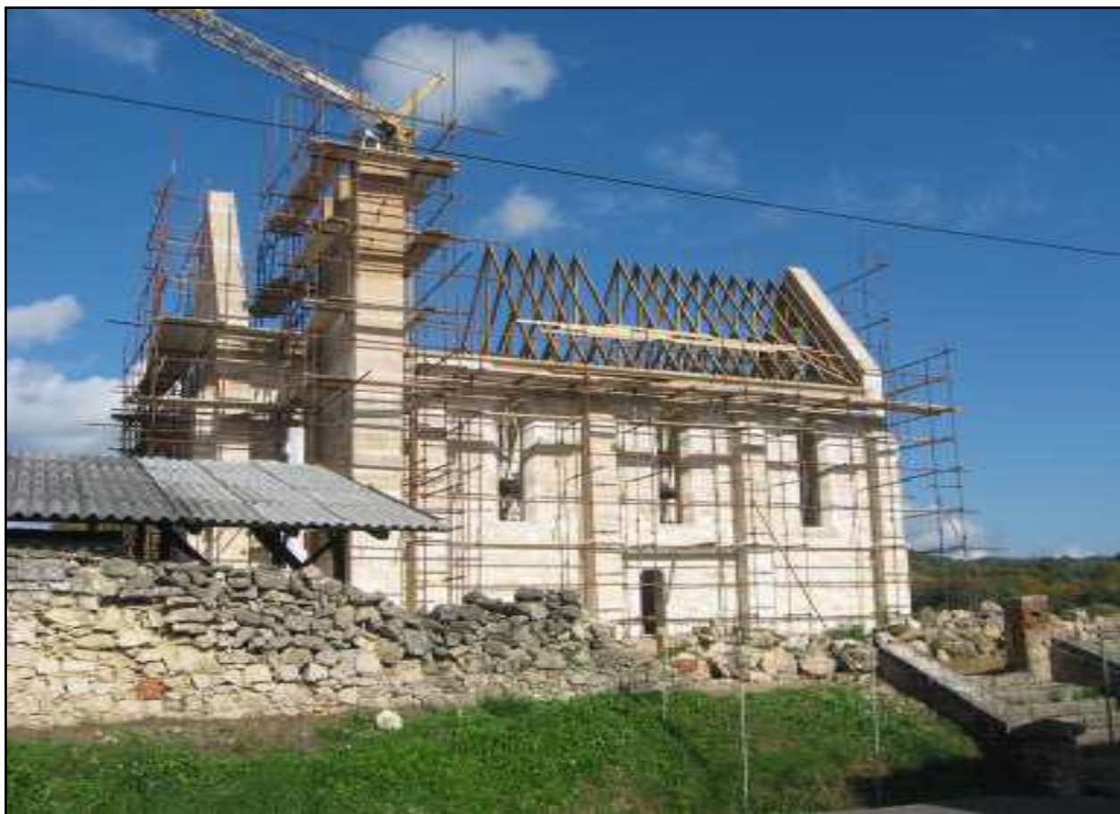
Slika 69. Vanjski pogled na konstrukciju krovšta i južno pročelje crkve
