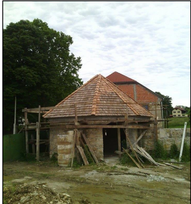
Slika 105. Postava šindre na krovšte kule
