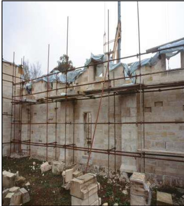
Slika 51. Detalj oštećenja zamjenskog kamena (1)
