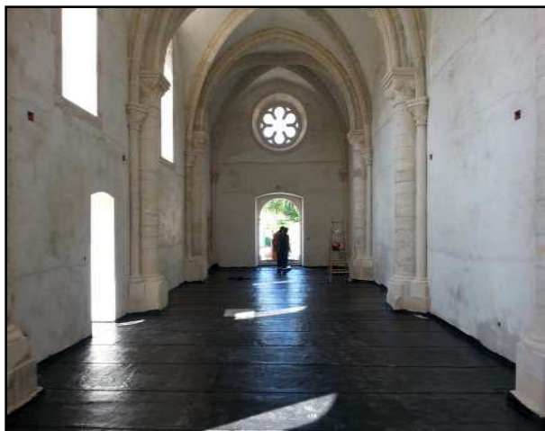
Slika 85. Izvedena hidroizolacija podne ploče (2)
