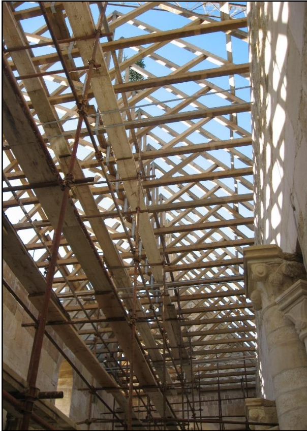
Slika 70. Pogled na konstrukciju krovišta (1)
