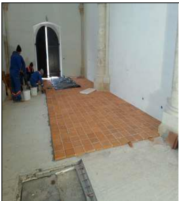
Slika 88. Popločenje poda tavelama
