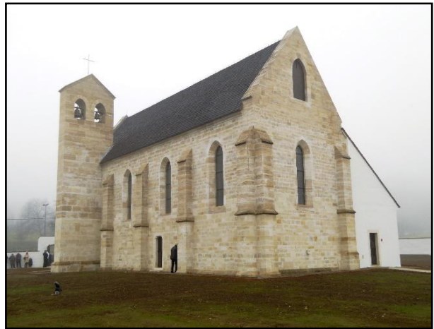
Slika 120. Pogled na sjeverno pročelje
