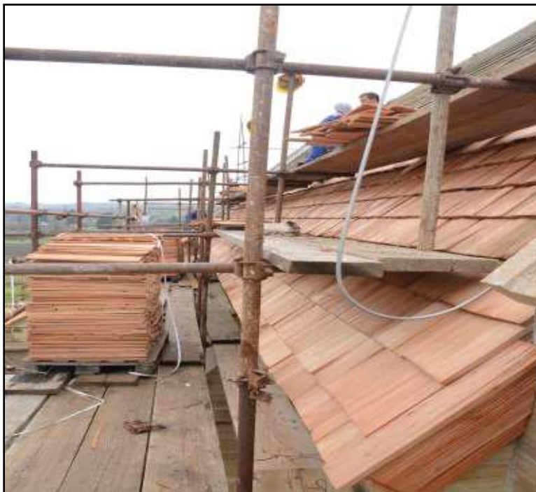
Slika 73. Postavljanje šindre (2)
