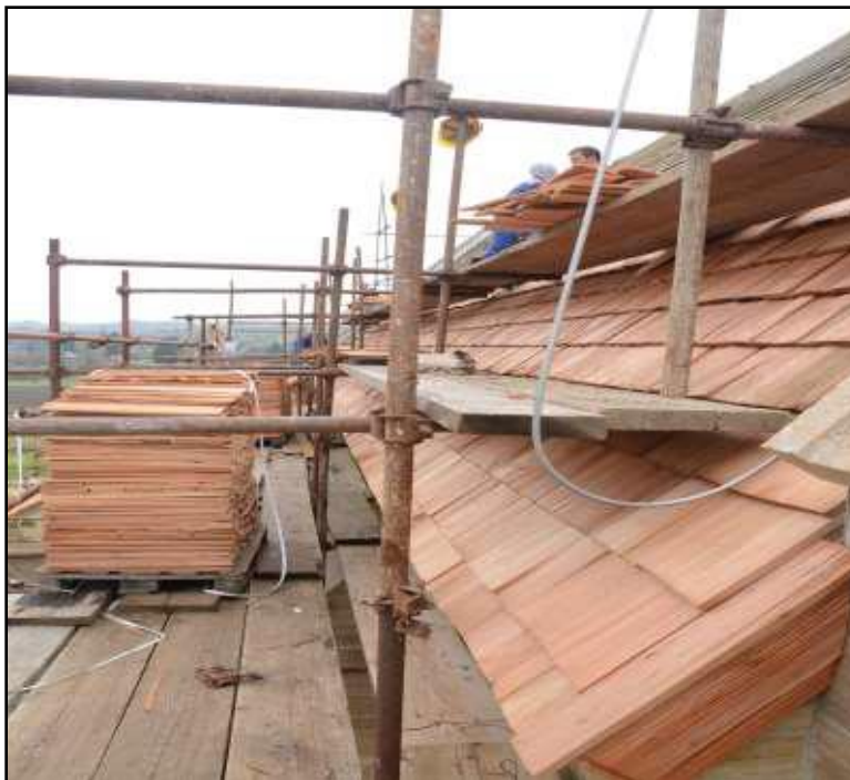
Slika 73. Postavljanje šindre (2)
