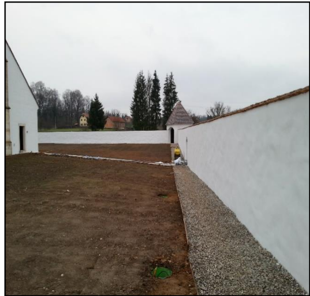
Slika 102. Pogled na južni i istočni zid
