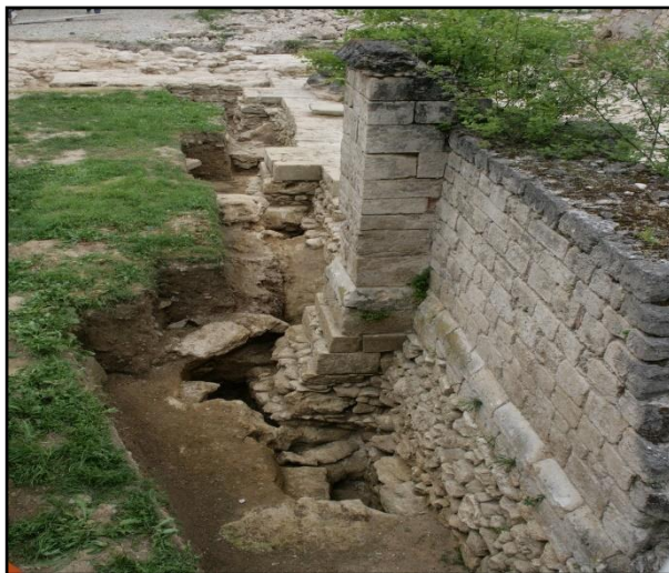
Slika 18. Ostaci kontrafora
