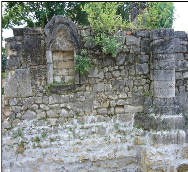
Slika 90. Sakrarij na južnom zidu
