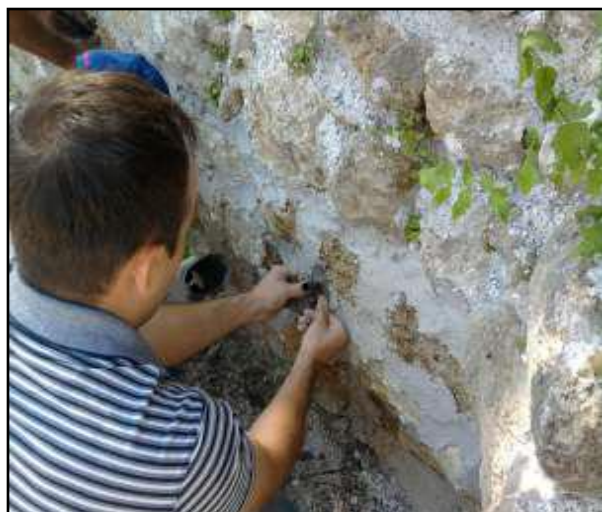
Slika 42. Ugrađivanje cjevčica u temelj
