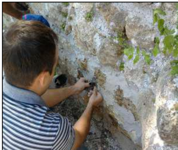
Slika 42. Ugrađivanje cjevčica u temelj
