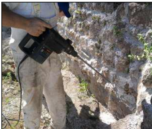
Slika 41. Bušenje temelja
