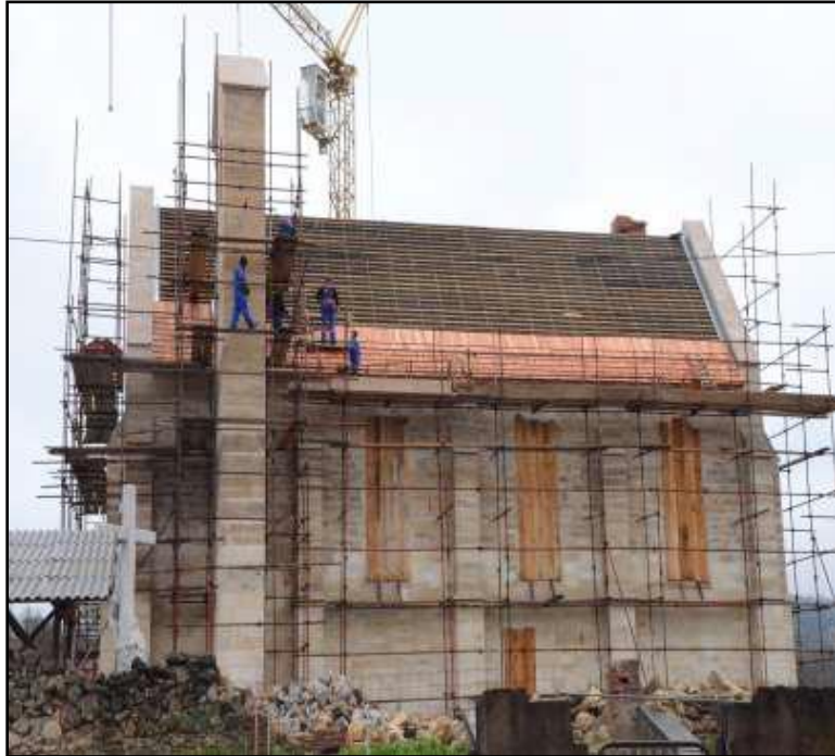
Slika 72. Postavljanje šindre (1)
