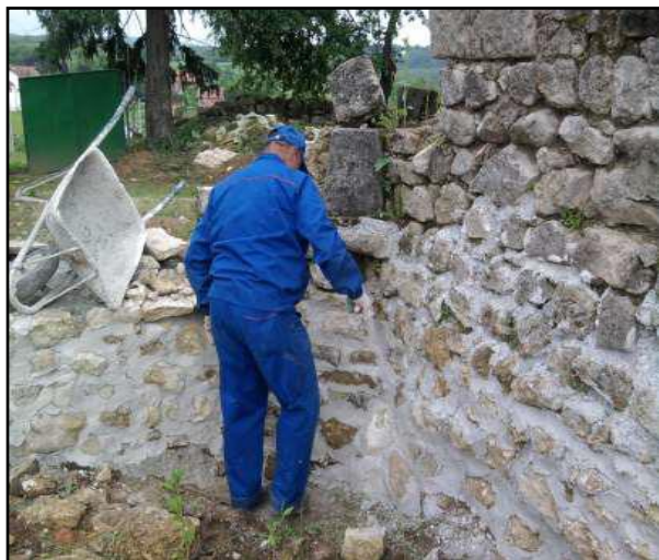
Slika 39. Špricanje temelja mortom
