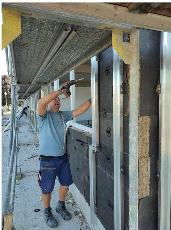
Slika 17. Montaža podkonstrukcije [18]
