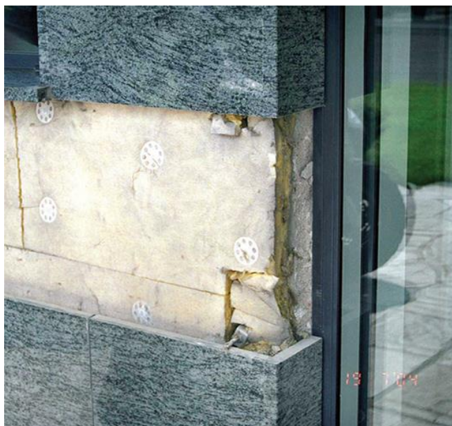
Slika 36. Kamena obloga na direktnim nosačima [46]
