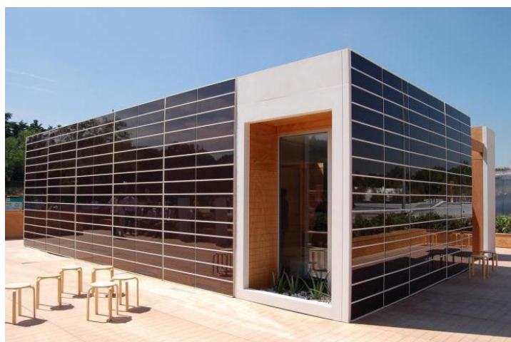
Slika 37. Staklena obloga ventilirane fasade [17]
