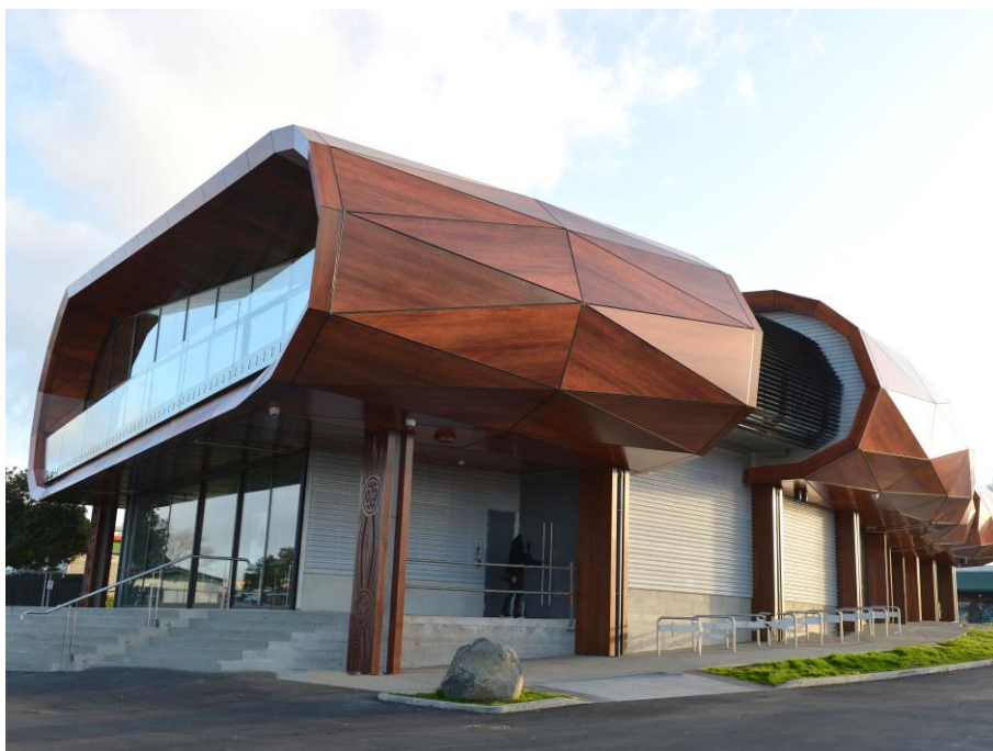
Slika 26. Kompozitni panel kao fasadna obloga [31]
