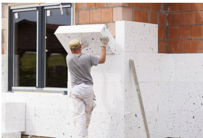
Slika 4. Lijepljenje EPS ploča [7]
