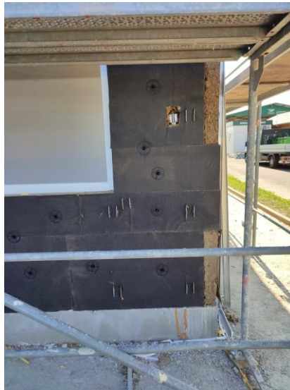
Slika 24. Tiplana izolacija kamene vune [18]
