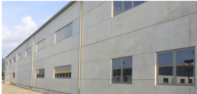
Slika 9. Fasada od betonskih elemenata [14]
