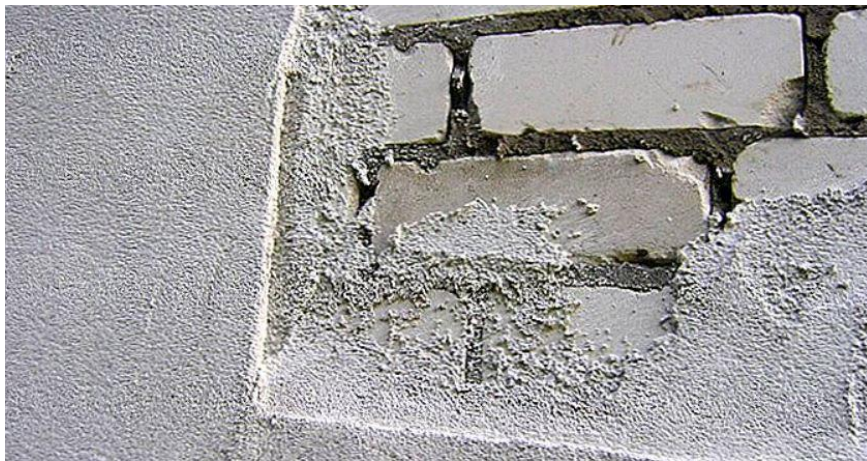
Slika 1. Vapneno - cementna žbuka [2]
