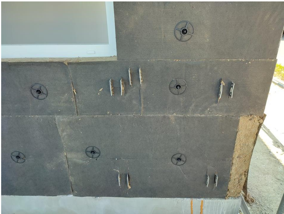
Slika 13. Kamena vuna u sustavu ventilirane fasade [18]
