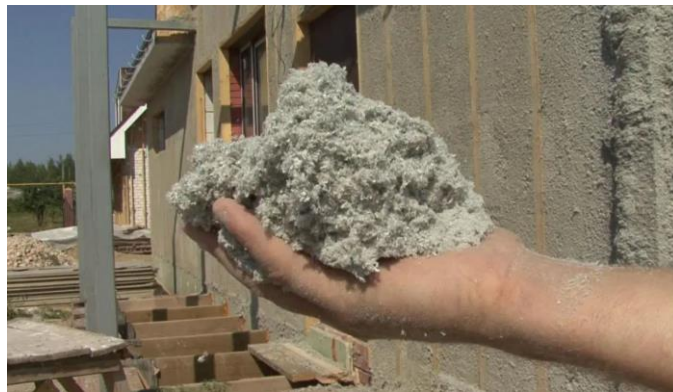
Slika 5. Izolacija celuloznom vunom [9]
