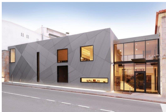
Slika 29. Vlaknocementna ploča kao fasadna obloga [39]
