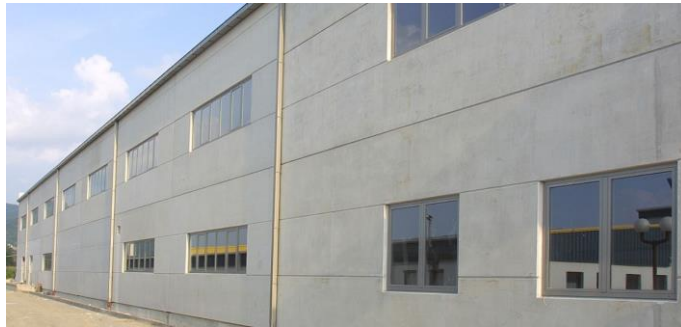
Slika 9. Fasada od betonskih elemenata [14]
