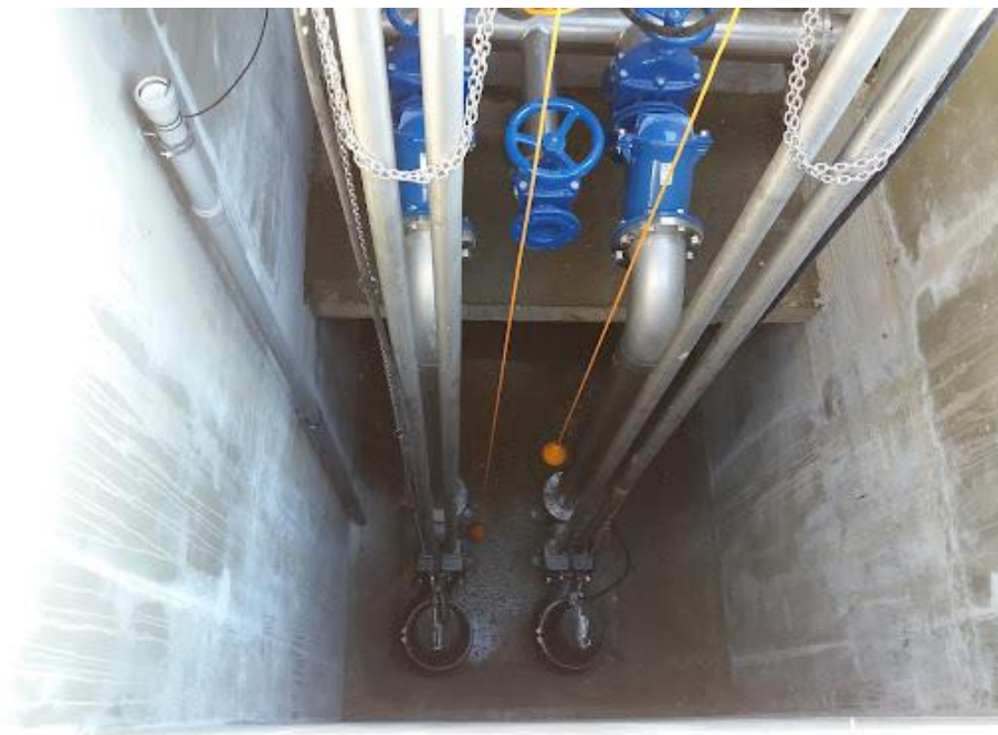
Slika 9: Primjer crpne stanice s dvije crpke [10]
