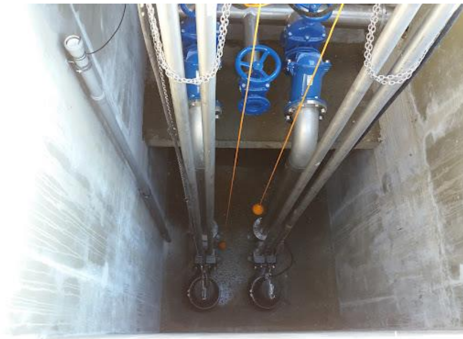
Slika 9: Primjer crpne stanice s dvije crpke [10]
