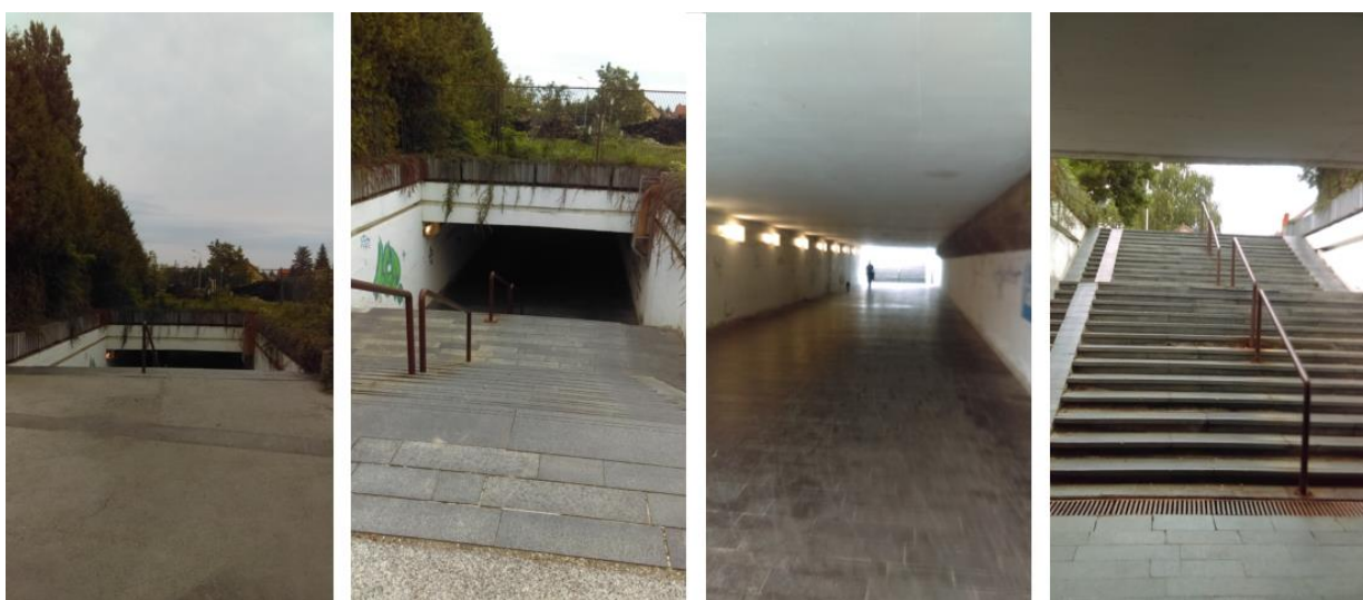
Slika 4.21 Slike postojećeg pothodnik za pješake [7]
