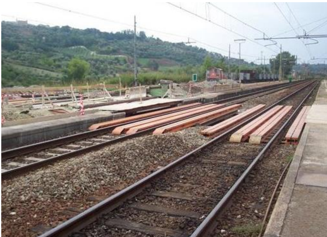
Slika 5.14 Tipičan primjer izgradnje pješačkog pothodnika [2]
