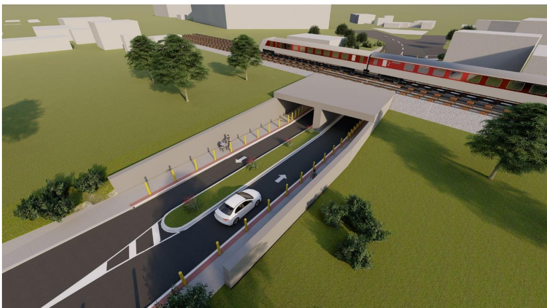
Slika 4.24 3D vizualizacija koncepta prenamjene postojećeg pothodnika u podvožnjak i pothodnik
