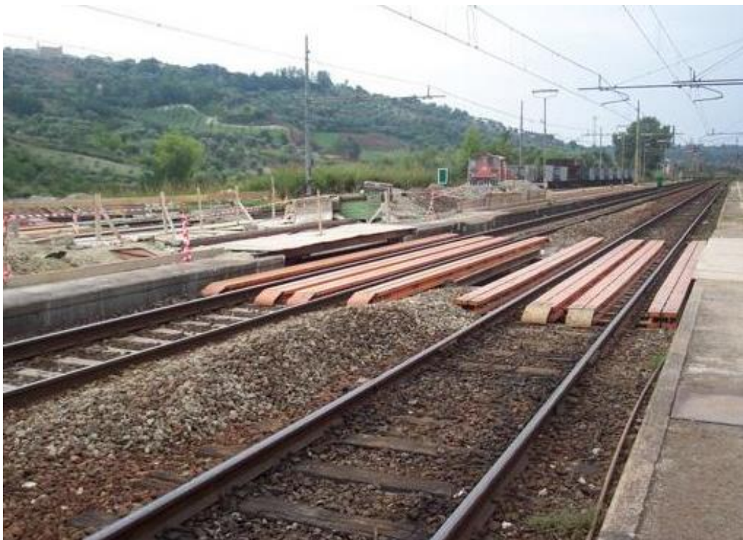
Slika 5.14 Tipičan primjer izgradnje pješačkog pothodnika [2]
