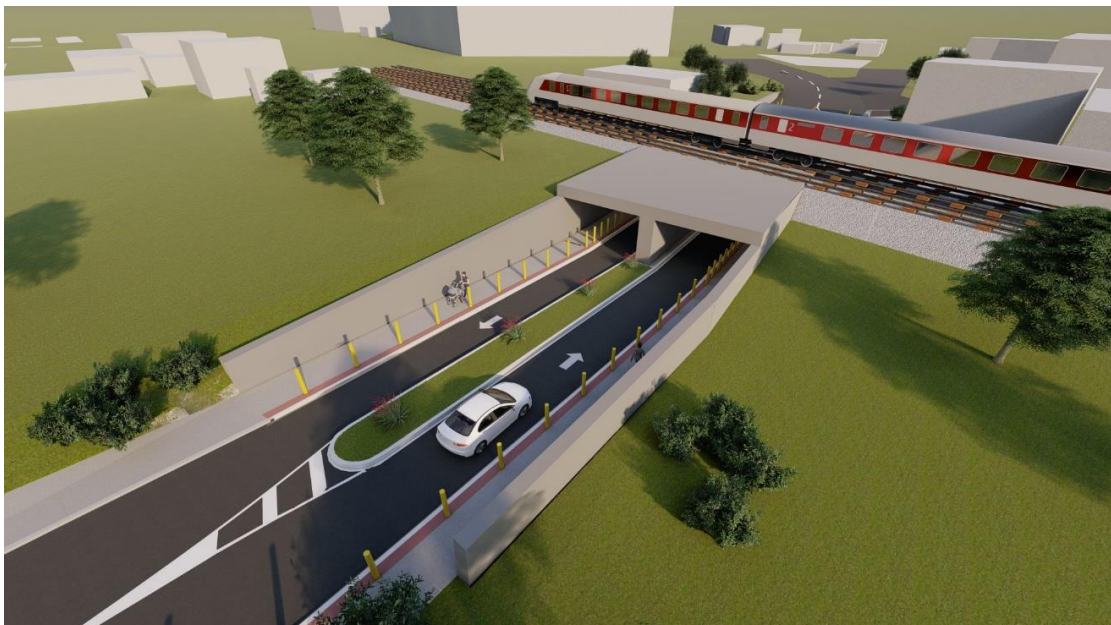
Slika 4.24 3D vizualizacija koncepta prenamjene postojećeg pothodnika u podvožnjak i pothodnik
