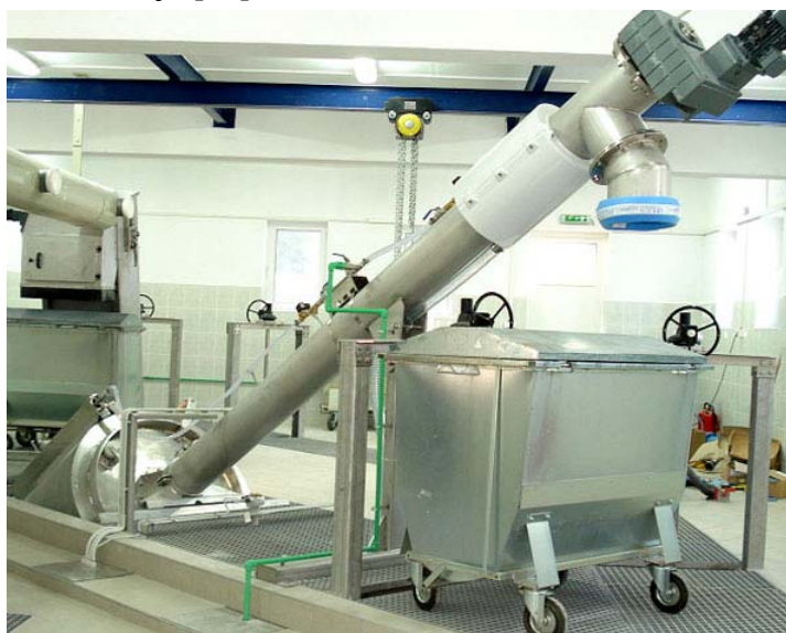
Slika 4.3. Primjer automatske fine rešetke [19]
