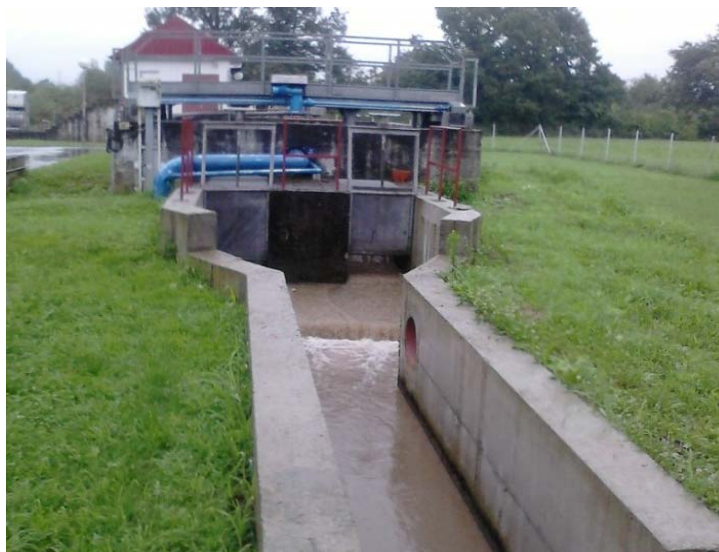
Slika 4.1. Primjer dovodnog kanala [18]
