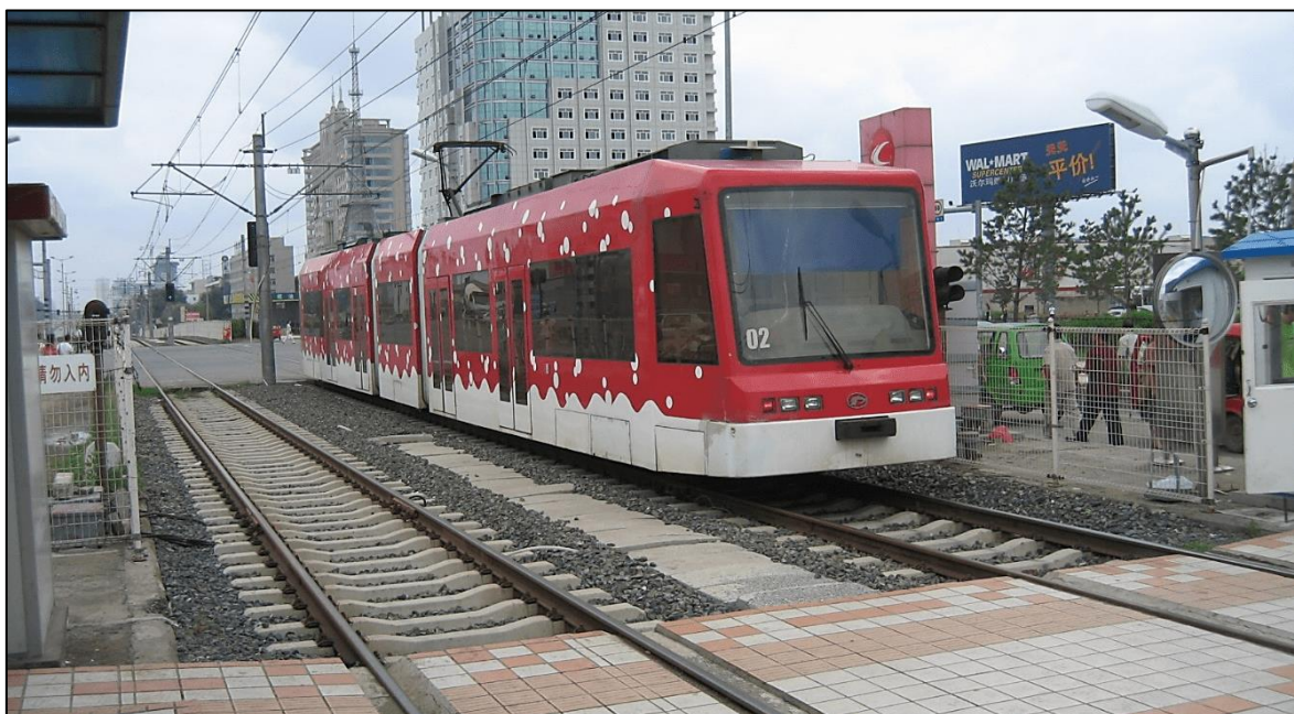
Slika 4.9. Vozilo lake gradske željeznice
