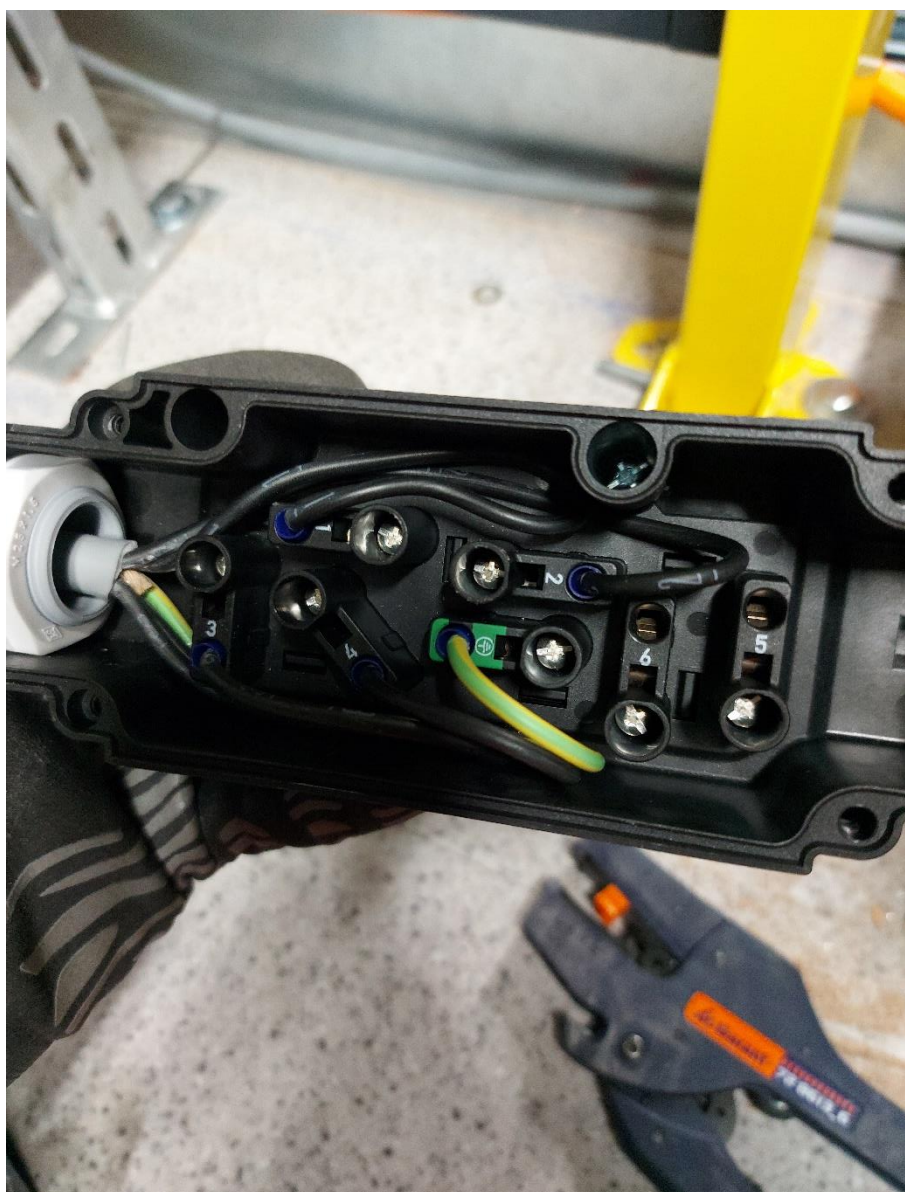
Slika 6.5 Priključni modul sa 5 žica za 400V
