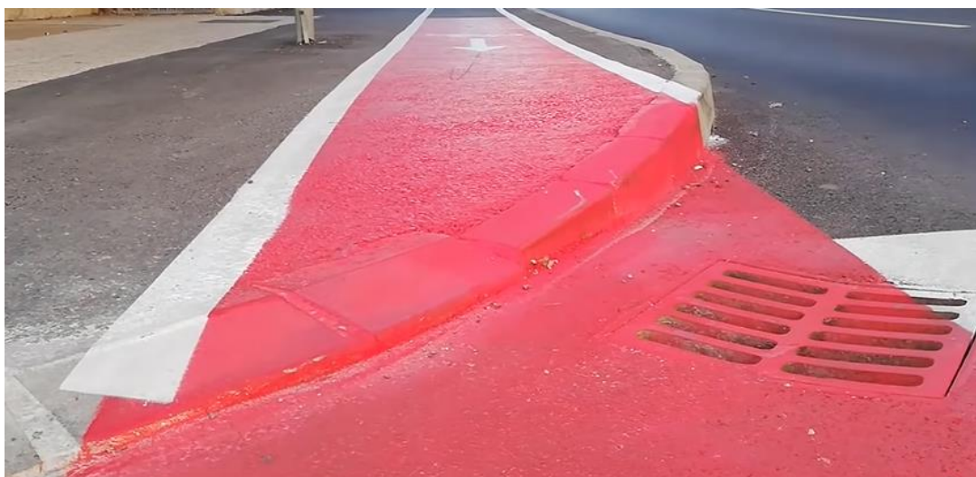
Slika 3.3.5. Uključivanje biciklističkog traka na kolnik (3)
