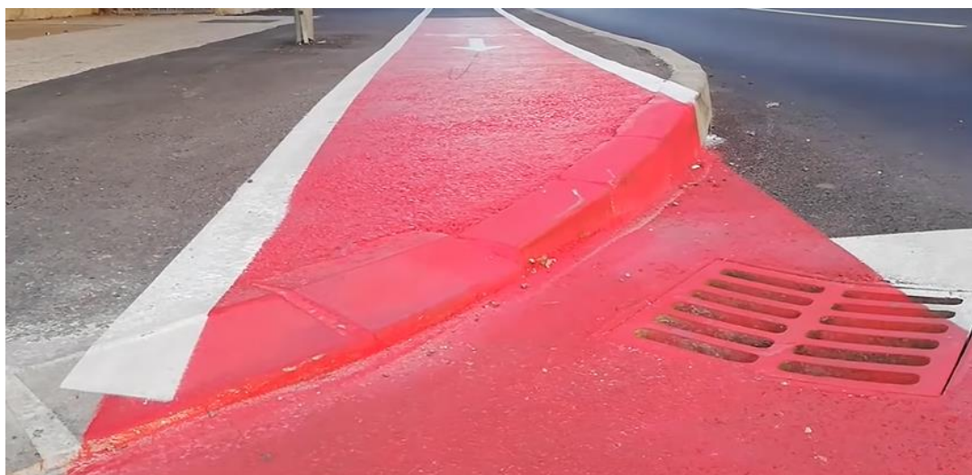
Slika 3.3.5. Uključivanje biciklističkog traka na kolnik (3)
