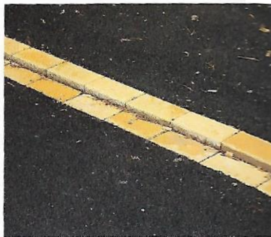
b) postavljanjem betonskog elementa
