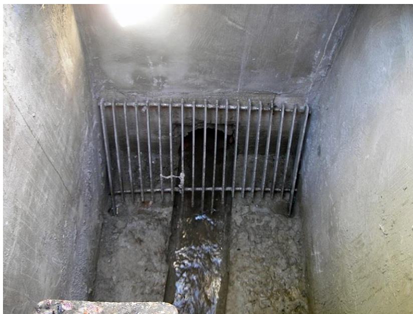
Slika 7: Gruba rešetka u ulaznom šahtu [11]
