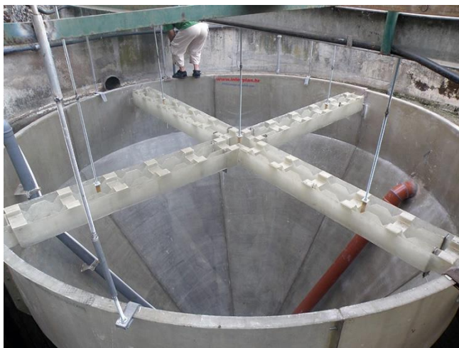
Slika 11: Sekundarni taložnik sa preljevnim križem [11]
