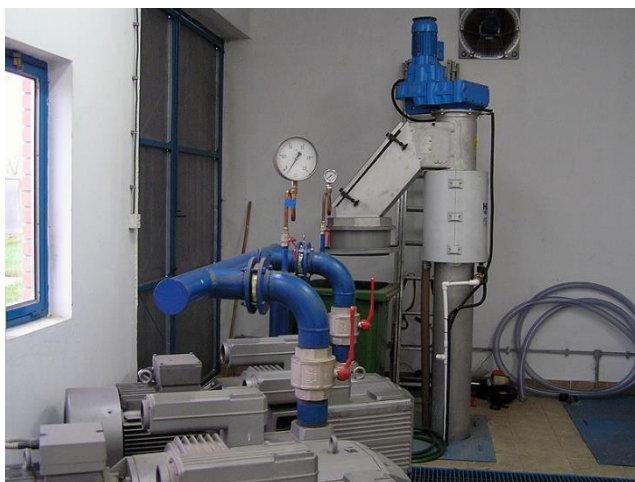
Slika 8: Primjer vertikalnog pužnog sita [6]
