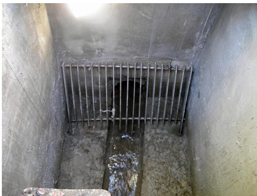
Slika 7: Gruba rešetka u ulaznom šahtu [11]
