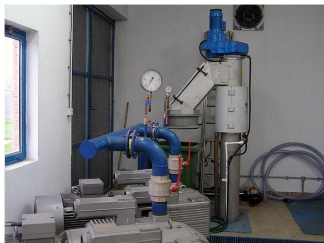
Slika 8: Primjer vertikalnog pužnog sita [6]
