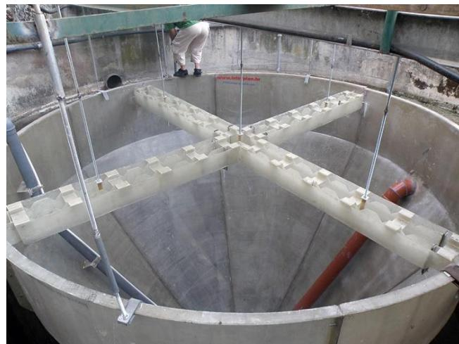
Slika 11: Sekundarni taložnik sa preljevnim križem [11]
