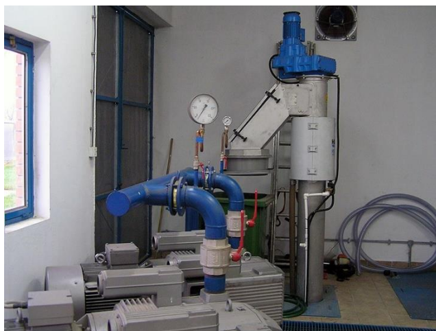
Slika 8: Primjer vertikalnog pužnog sita [6]
