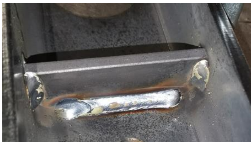
Slika 4.13. Zavarena druga pločica s prednje strane
