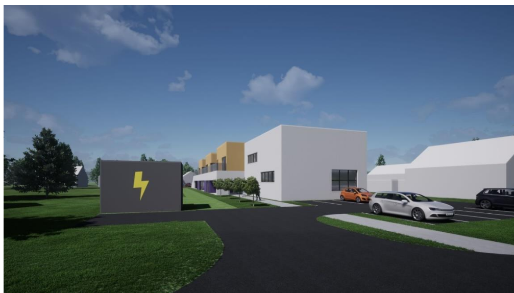
Slika 2. Prikaz zgrade dječjeg vrtića sa ulazne strane
