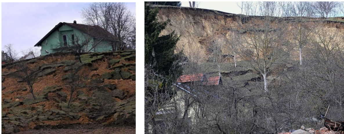
Slika 1.2.: Klizišta u Hrvatskoj Kostajnici [3]
