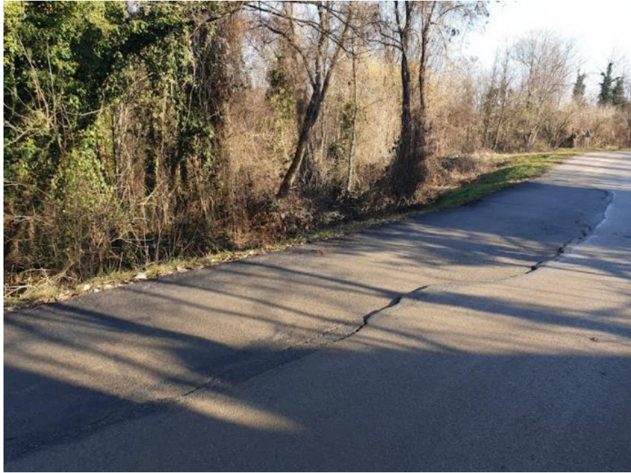
Slika 2.8.: Polagano puzanje mase koje uzrokuje klizanje [3]
