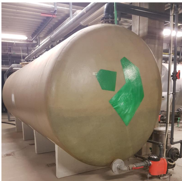
Slika 3.4 Kompenzacijski spremnik (vlastiti izvor)
