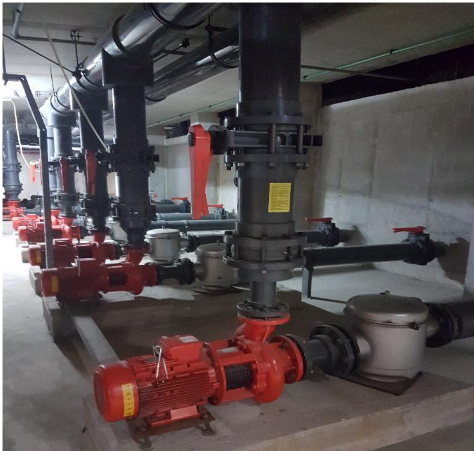
Slika 3.2 Filterske crpke s pred filterom (vlastiti izvor)
