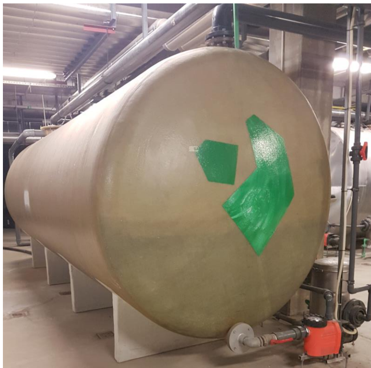
Slika 3.4 Kompenzacijski spremnik (vlastiti izvor)
