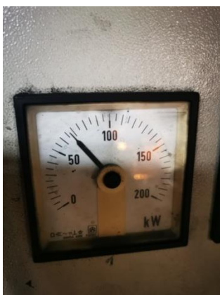
Slika 5.1. Mjerač snage kod normalnog režima rada [8]
