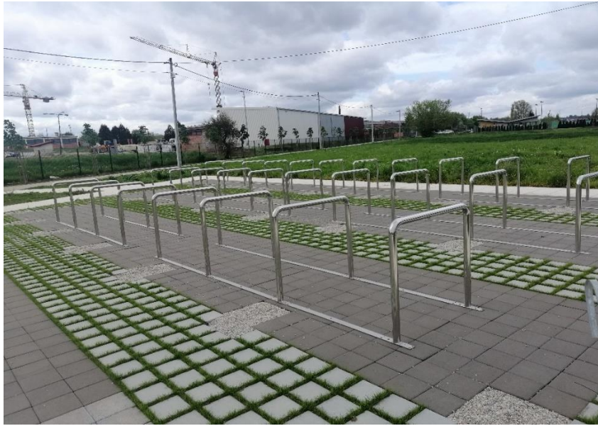
Slika 6. Parkiralište za bicikle kod željezničkog kolodvora u Križevcima
