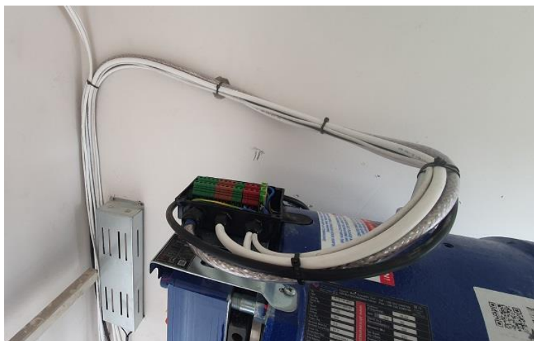
Slika 16. Priključna kutija elektromotora [3]
