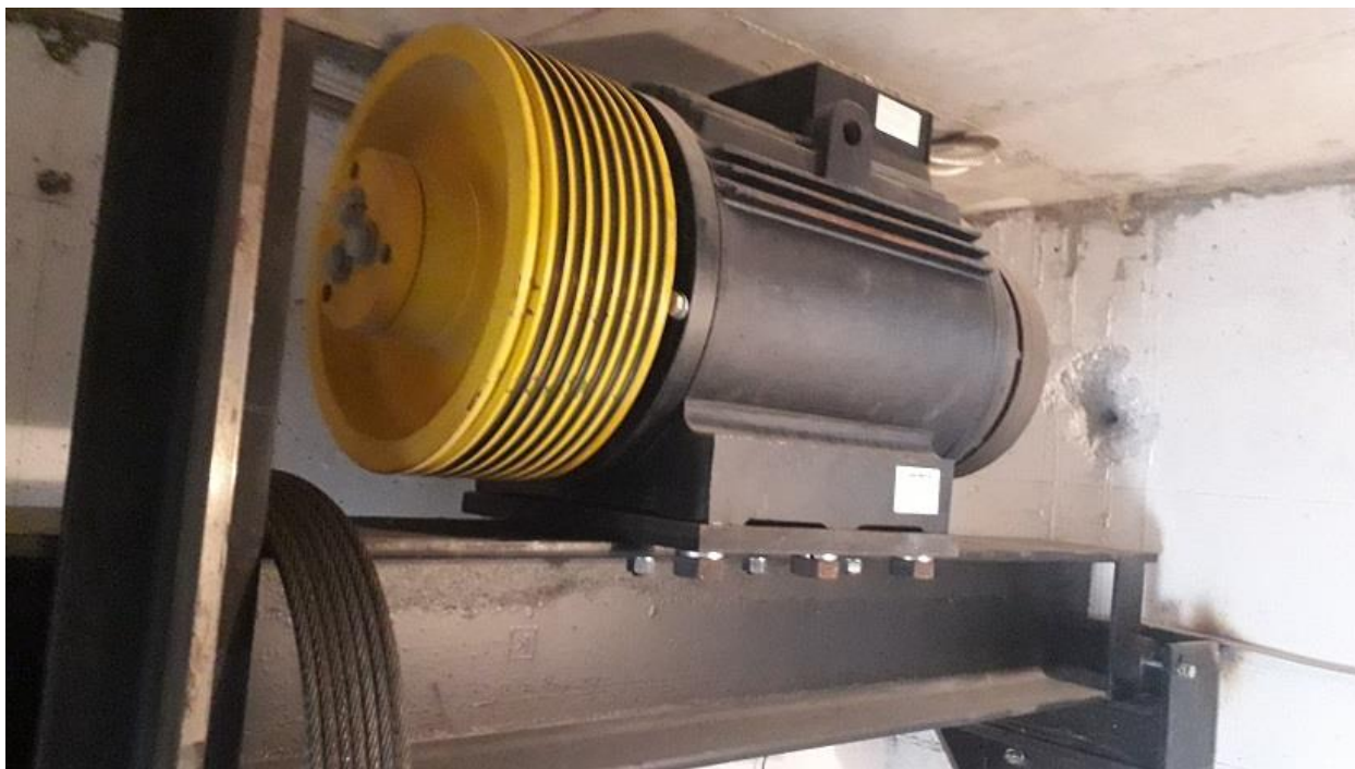
Slika 2. Elektromotor bez reduktora (Starački dom Zaprešić)
