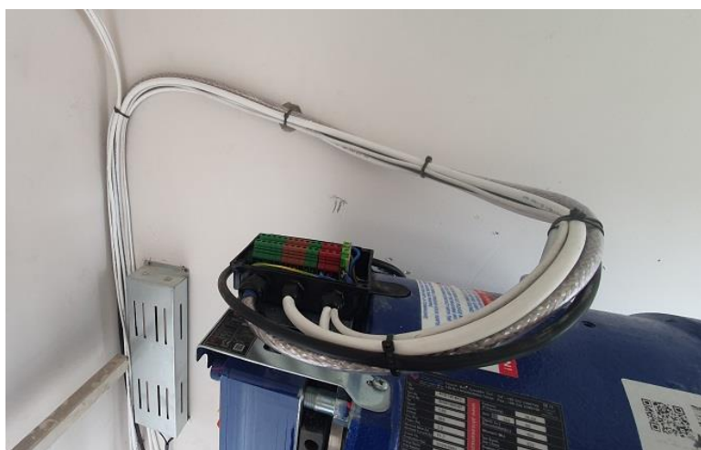
Slika 16. Priključna kutija elektromotora [3]
