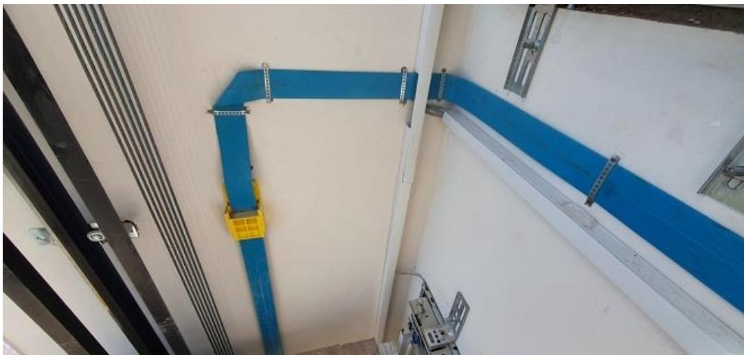
Slika 24. Električne instalacije u voznom oknu [3]
