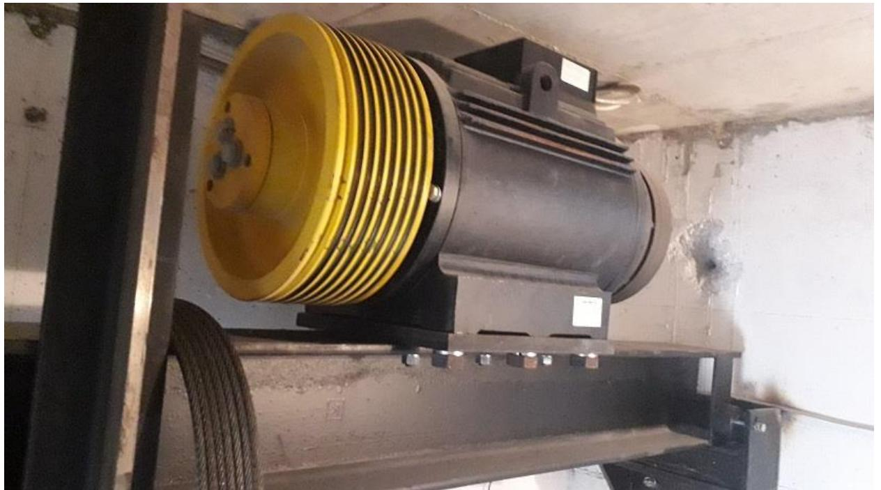
Slika 2. Elektromotor bez reduktora (Starački dom Zaprešić)
