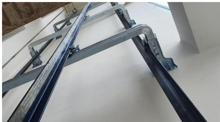
Slika 12. Montirane vodilice [3]
