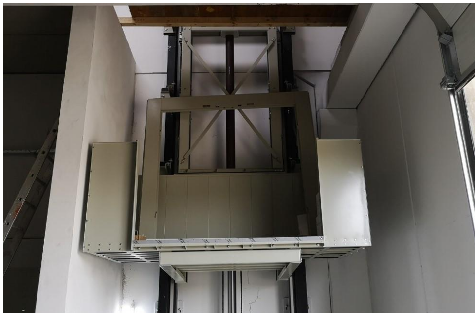
Slika 4. Teretna platforma tijekom montaže (skladište u Macincu)
