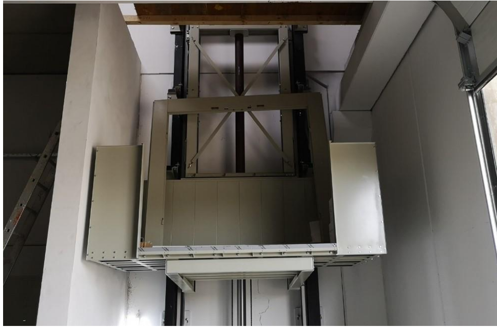
Slika 4. Teretna platforma tijekom montaže (skladište u Macincu)
