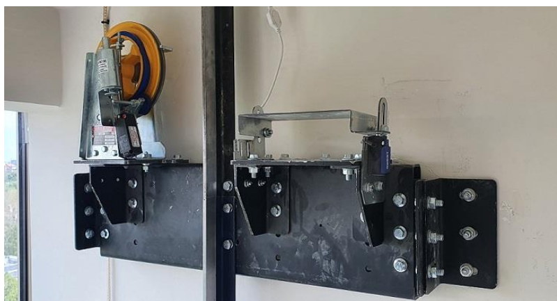
Slika 14. Nosač čelične užadi i regulatora brzine [3]
