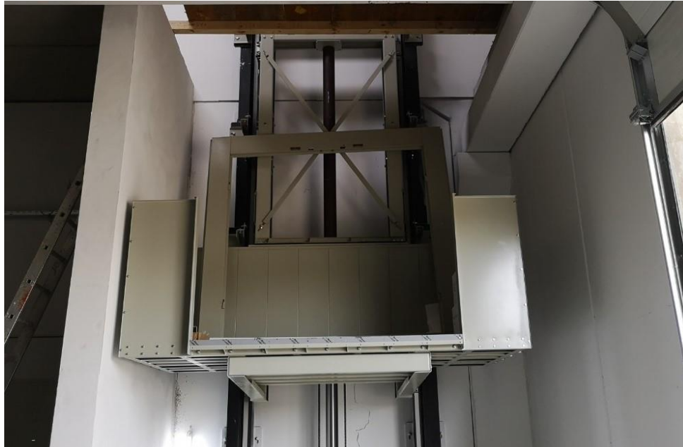
Slika 4. Teretna platforma tijekom montaže (skladište u Macincu)
