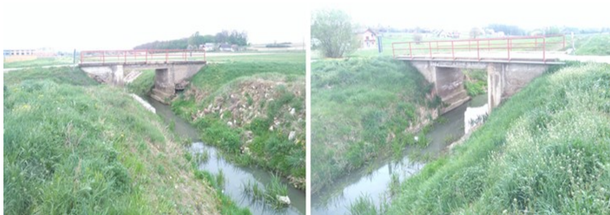
Slika 3.2. Postojeći most preko potoka Koruška
