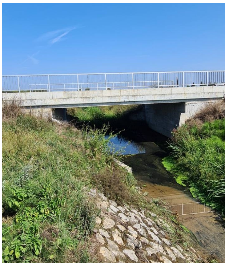
Slika 6.2. Izvedeno stanje – jugoistočni pogled na most
