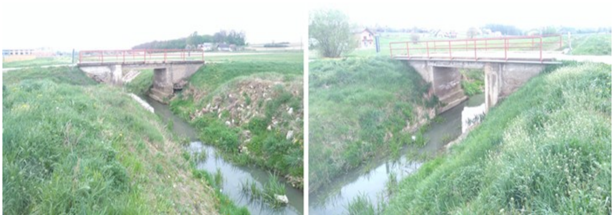
Slika 3.2. Postojeći most preko potoka Koruška
