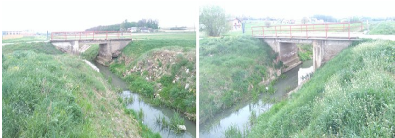
Slika 3.2. Postojeći most preko potoka Koruška
