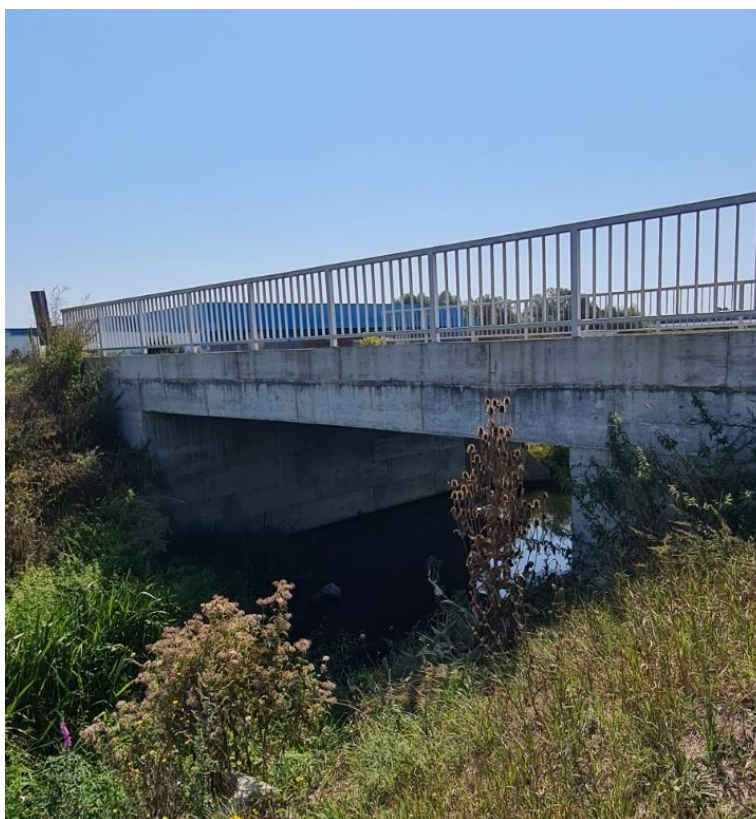
Slika 6.1. Izvedeno stanje – sjeverozapadni pogled na most
