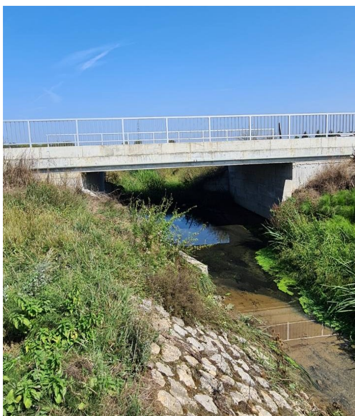
Slika 6.2. Izvedeno stanje – jugoistočni pogled na most
