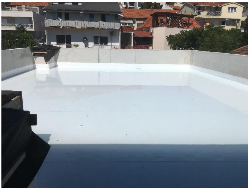
Slika 3.10 Izolacija prohodnog krova
