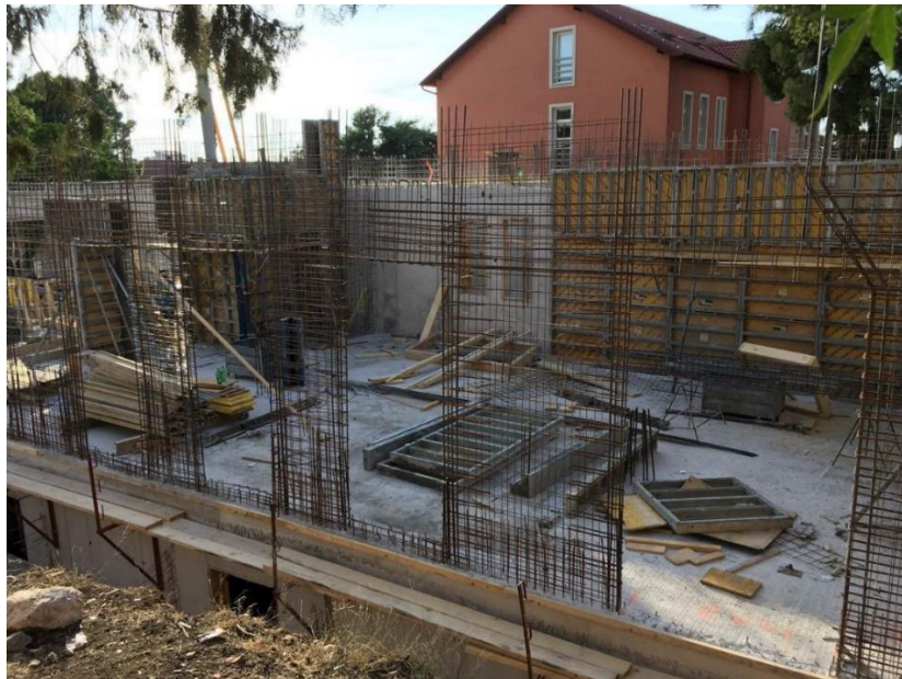
Slika 3.4 Armatura zidova
