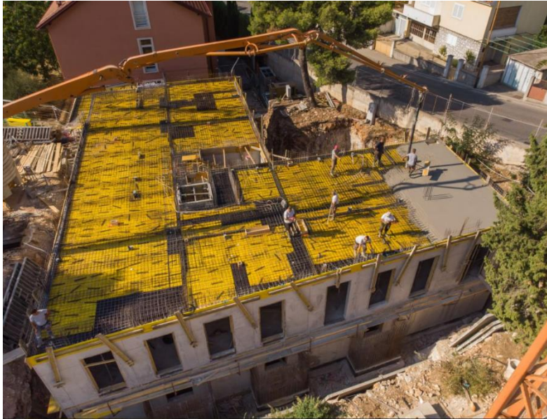
Slika 3.3 Betoniranje ploče
