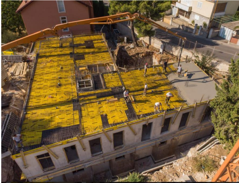
Slika 3.3 Betoniranje ploče
