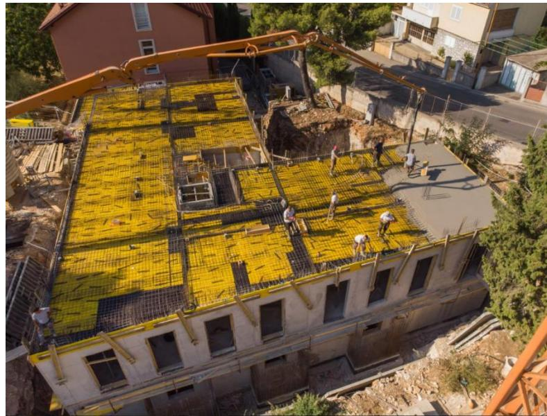
*Slika 3.3 Betoniranje ploče*
