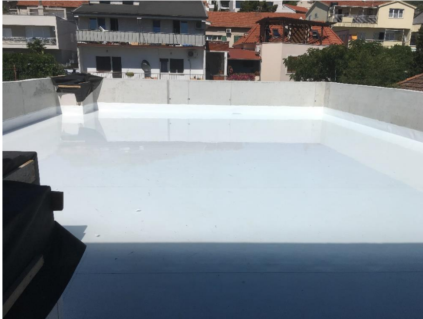
Slika 3.10 Izolacija prohodnog krova
