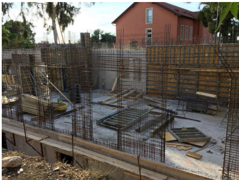
Slika 3.4 Armatura zidova
