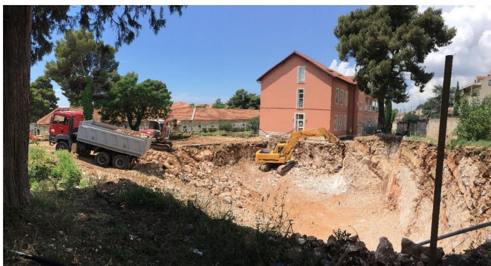
Slika 3.2 Iskop i odvoz materijala
