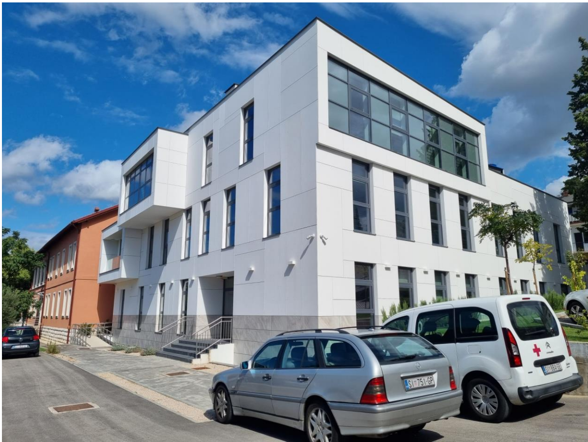
Slika 2.1 Prednja strana objekta
