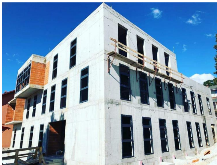
Slika 3.5 Prikaz zidanih dijelova
