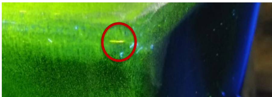
Slika 2.13 Indikacija u zavarenom spoju
