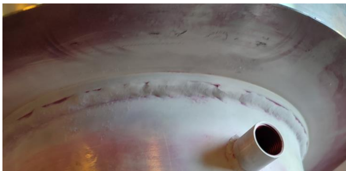
Slika 3.11 Nepravilnosti oblika zavarenog spoja
