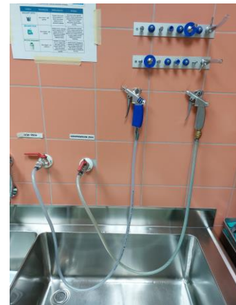
Slika 3.1.6. Pištolj na demivodu i komprimirani zrak (Izvor: L. B.)
