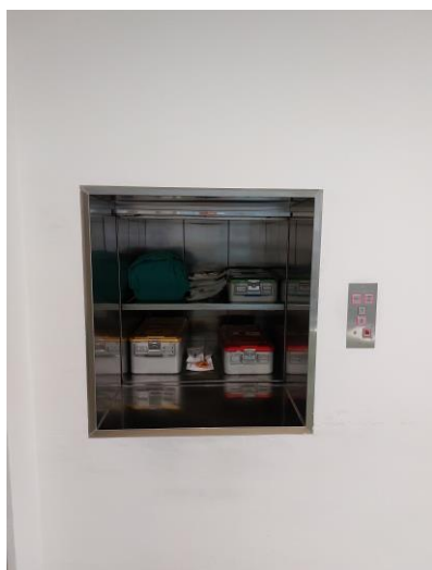
Slika 3.3.4. Dizalo za slanje sterilnih operacijskih kaseti i instrumenata (Izvor: L. B.)
