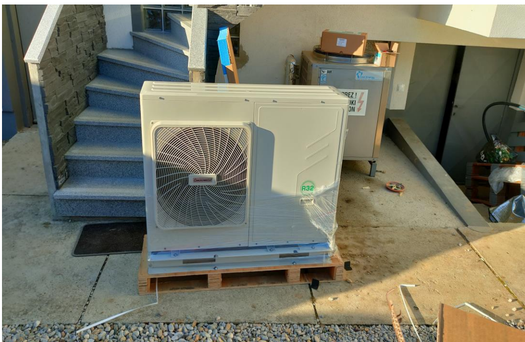
Slika 3.10 još neugrađena dizalica topline
