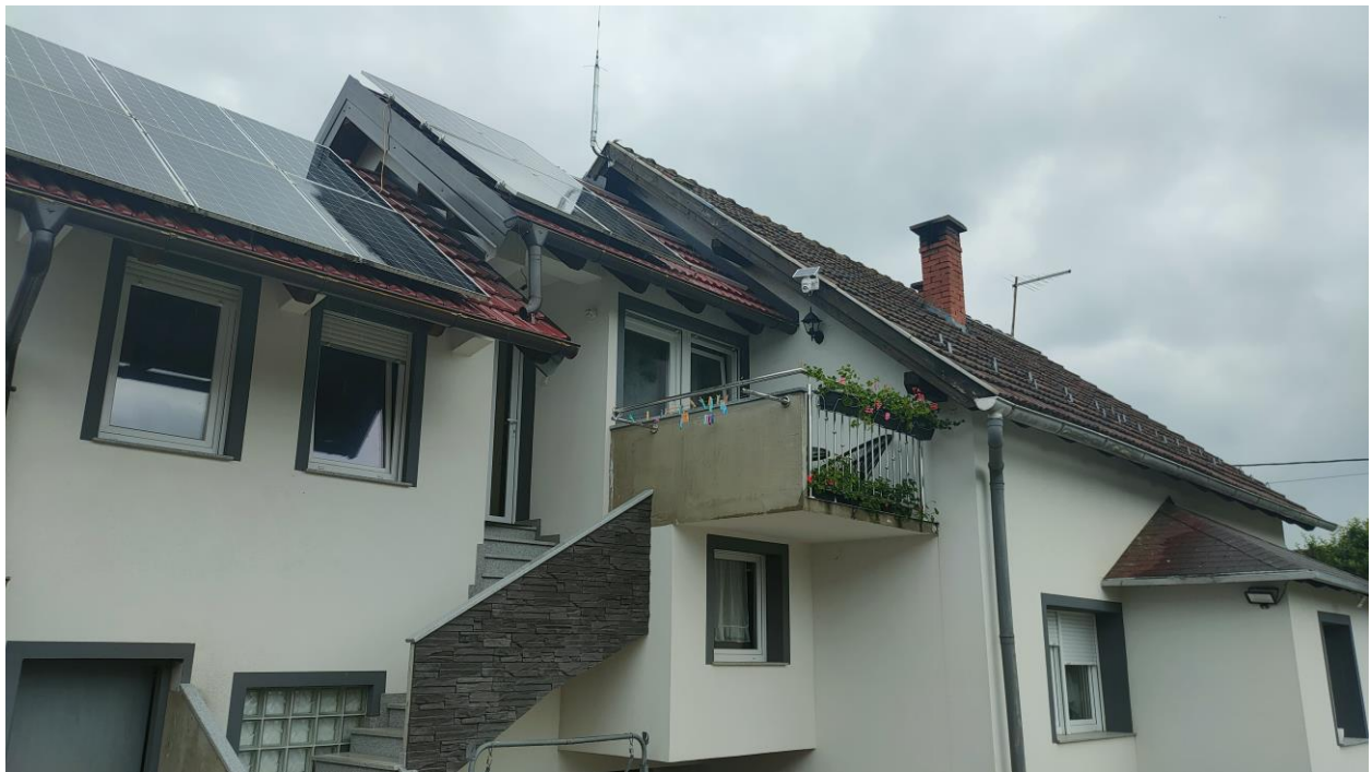
Slika 3.2 slika nakon postavljene termo fasade od 15 cm
