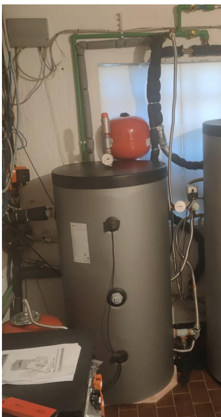
Slika 3.11 akumulacija topline za grijanje - puffer
