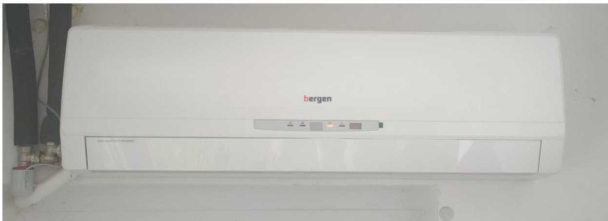
Slika 3.12 Ventilokonvektor za grijanje
