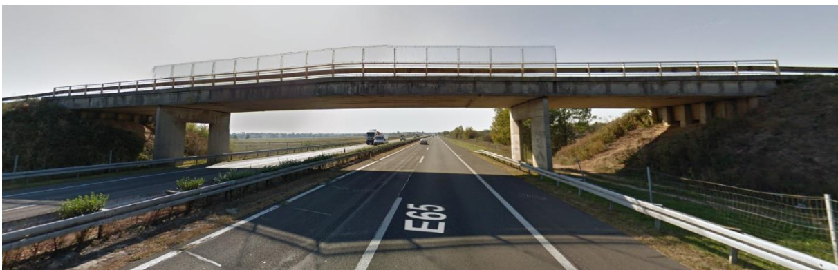
Slika 5. Nadvožnjak s tri otvora
