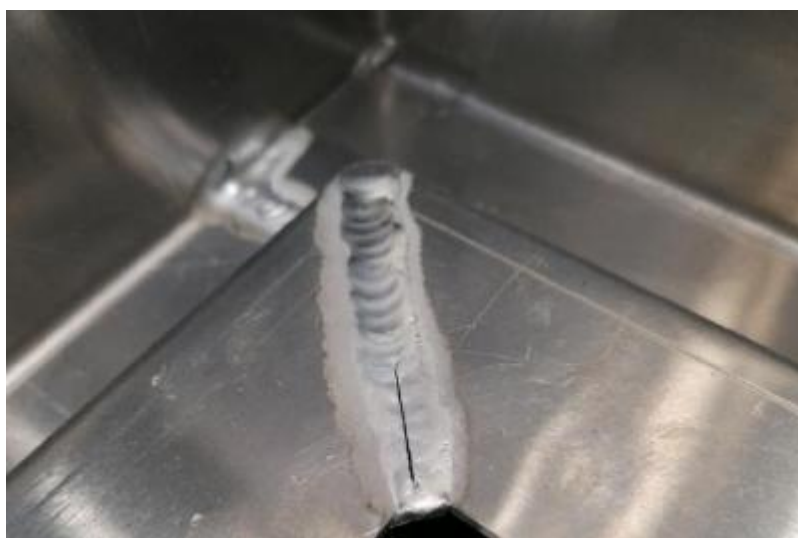
Slika 3.3. Pukotina u smjeru zavara [16]
