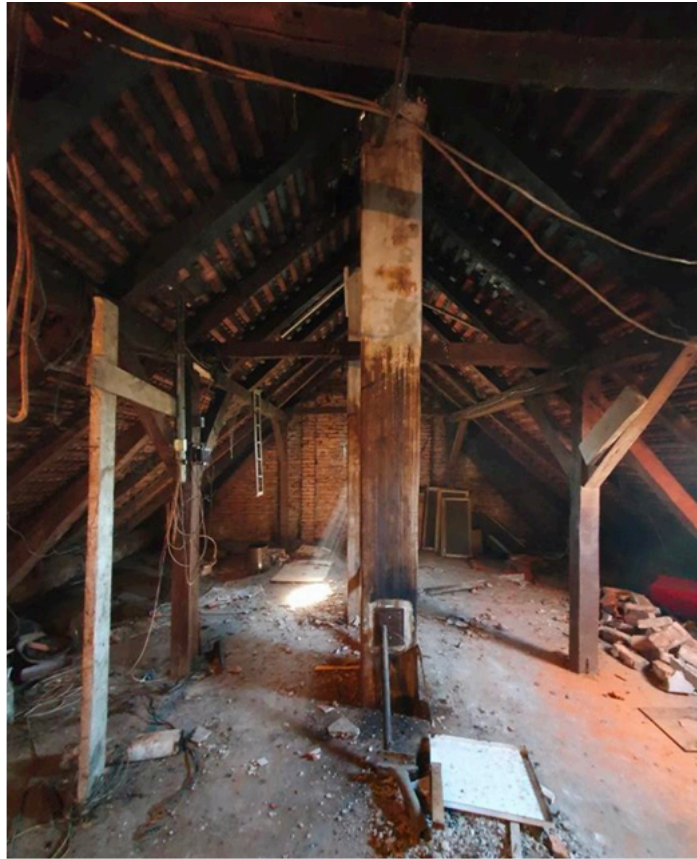
Slika 19. Krovna konstrukcija i dimnjak u potkrovlju predmetne građevine
