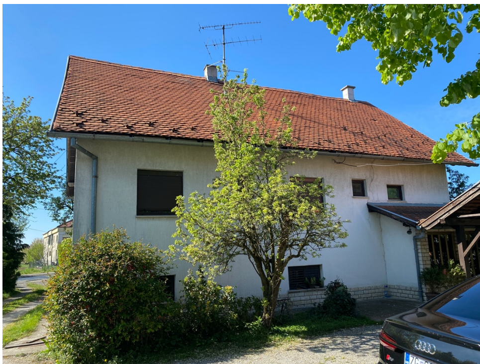
Slika 6. Sjeverno pročelje zgrade
