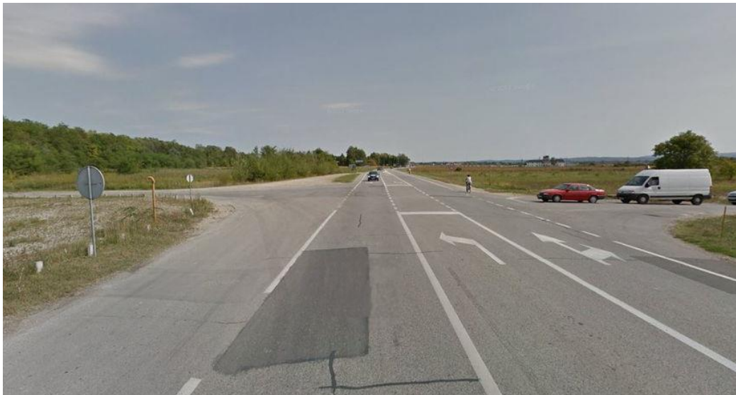
Slika 21 Raskrižje državne ceste D2 i Kućanske ulice – Varaždin (prije rekonstrukcije)
