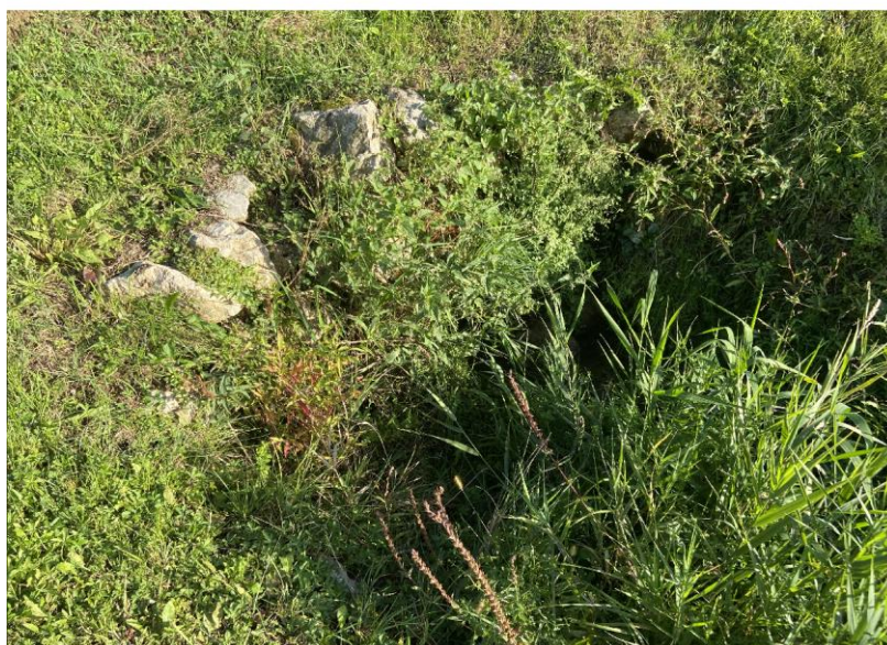
Slika 32. Neuređeni odvodni kanal i otvor u koji se ulijeva voda u podzemni tok
