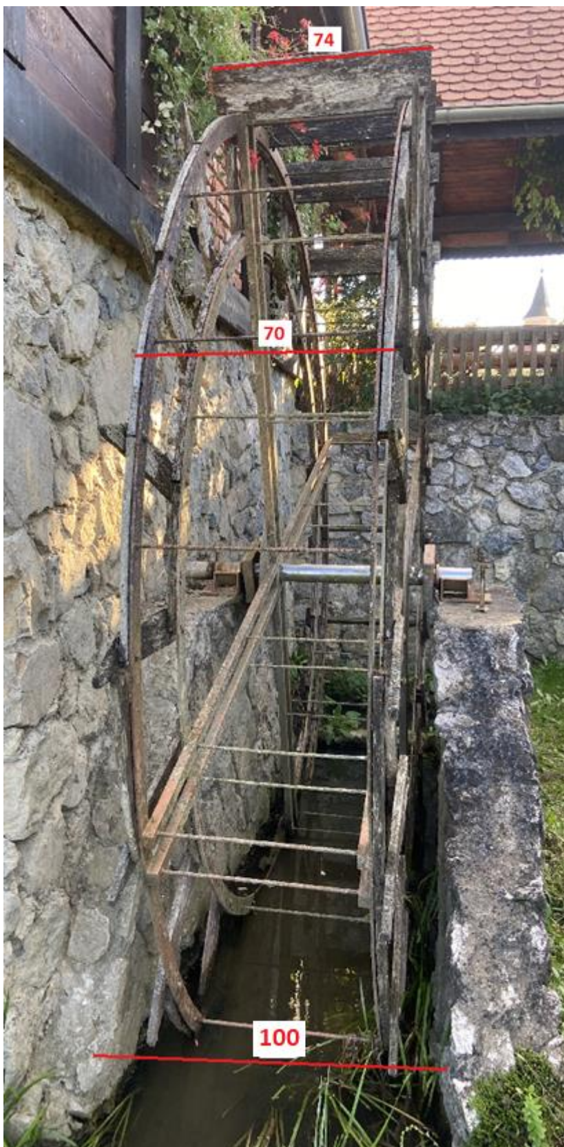
Slika 30. Prikaz dimenzija dijelova vodnog kola; dužine u cm
