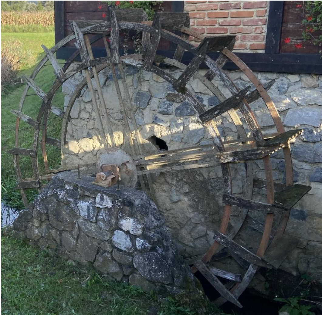
Slika 25. MliNSko kolo na mlinu u Margečanu, na rijeci Bednji, u dotrajalom stanju
