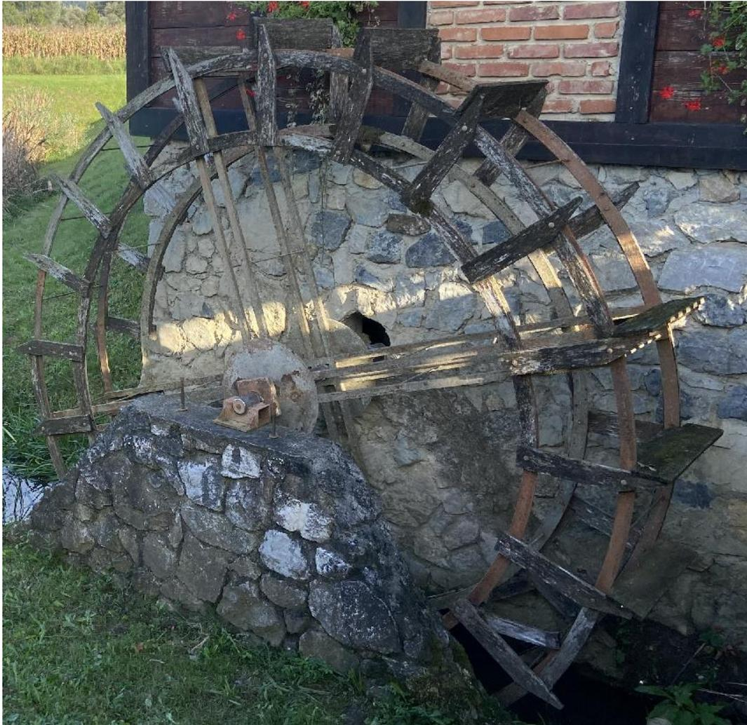
*Slika 25. MliNSko kolo na mlinu u Margečanu, na rijeci Bednji, u dotrajalom stanju*
