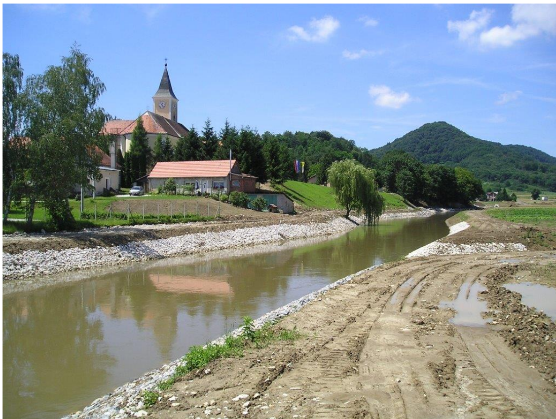
Slika 22. Rijeka Bednja u naselju Margečan [13]
