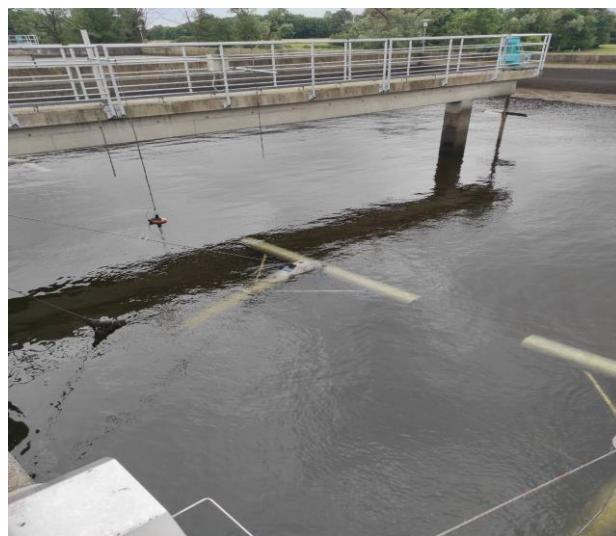
Slika 4.10. Izgled SBR reaktora prilikom faze sedimentacije
