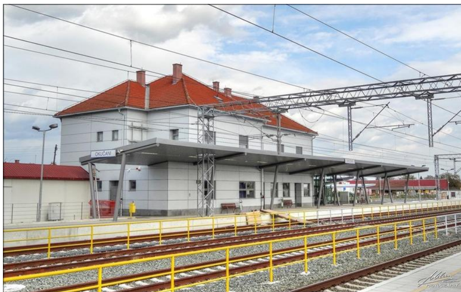
Slika 24. Primjer najljepšeg i najfunkcionalnijeg željezničkog kolodvora u Hrvatskoj, kolodvor Okučani
