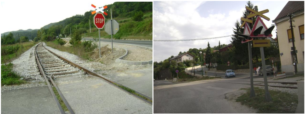
Slika 2. ŽCP u blizini Đurmanca (lijevo) i ŽCP u Krapini (desno)
