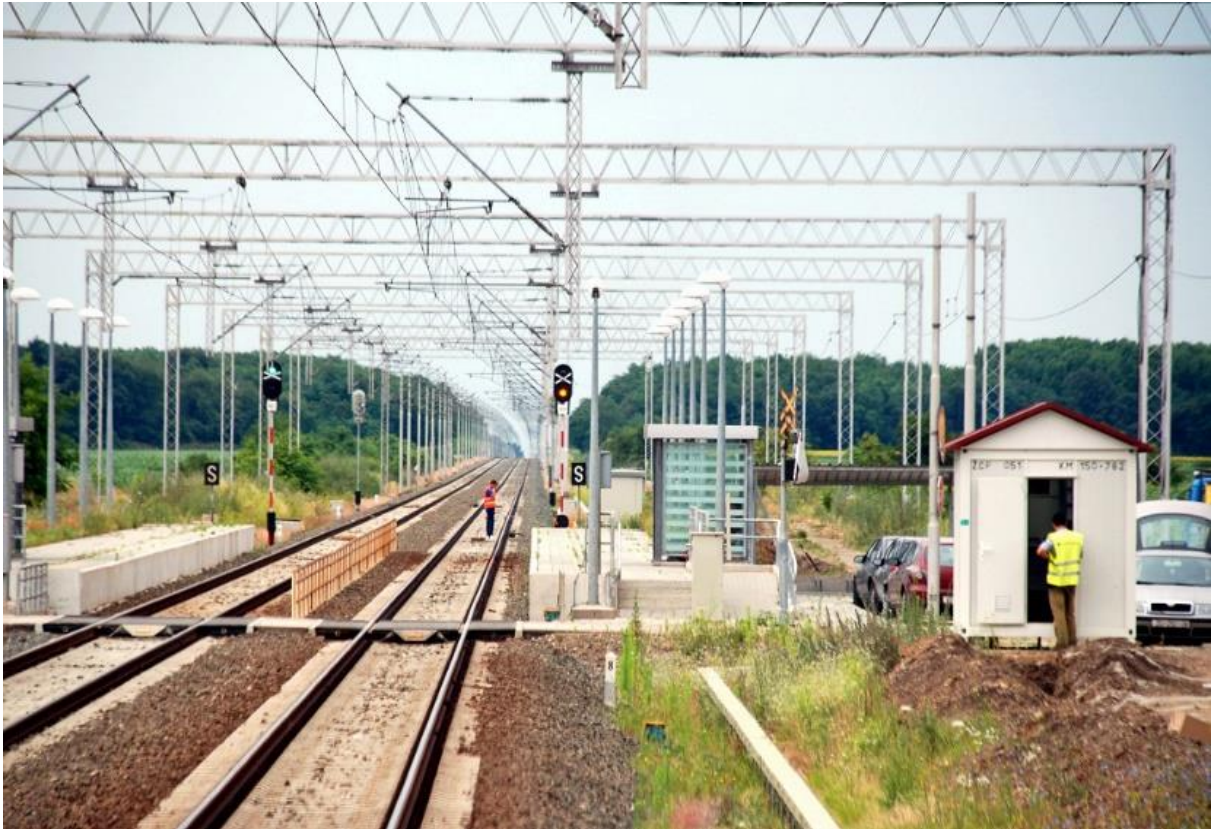
Slika 19. Primjer elektrifikacije i modernizacije pruge Vinkovci – Tovarnik – DG
