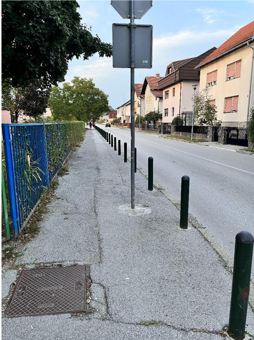
Slika 5. Dravska ulica nakon postavljanja sigurnosnih stupića
