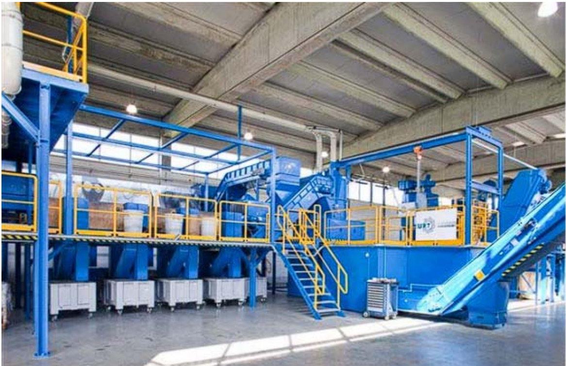
Slika 21. Prikaz postrojenja u Donjoj Bistri kraj Zagreba za oporabu EE otpada [34]
