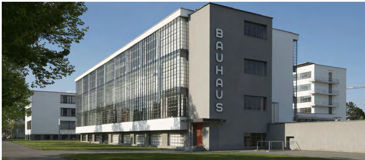
Slika 7: Zgrada Bauhauusa u Dessau, Njemačka
