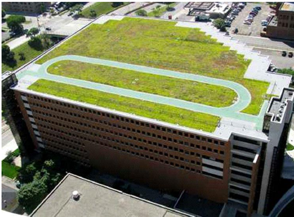
Slika 5. Zeleni krov parkinga zgrade u Michiganu
